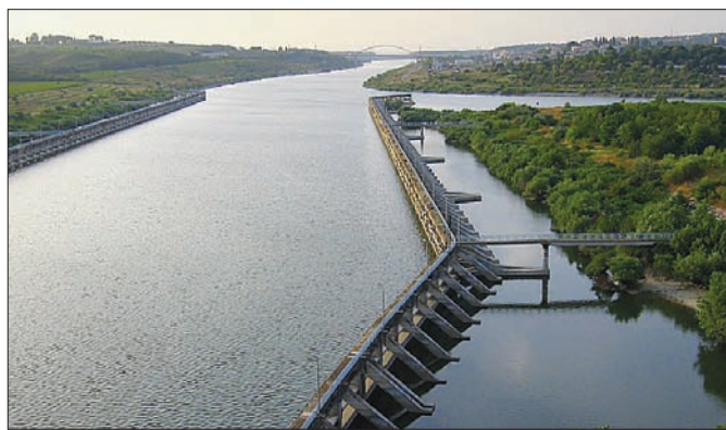
Fig. 7: Port așteptare amonte la ecluza Cernavodă. Vedere de ansamblu a zonelor de racordare (în prim plan) și acostare
