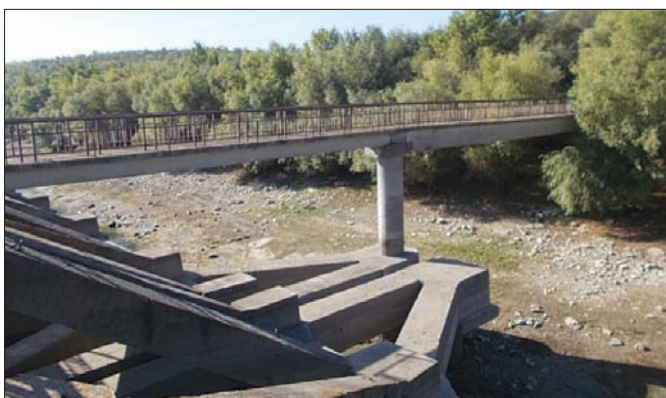
Fig. 6: Port așteptare amonte la ecluza Cernavodă. Pasarelă de acces
