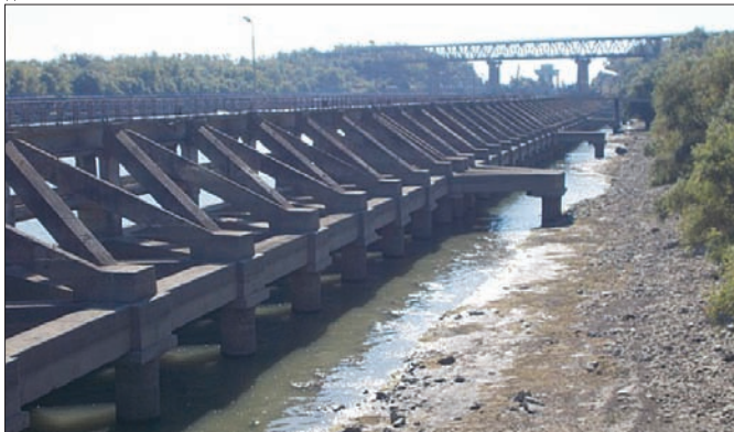
Fig. 3: Port așteptare amonte la ecluza Cernavodă. Zona de acostare văzută dinspre uscat la ape mici ale Dunării
