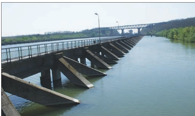
Fig. 5: Port așteptare amonte la ecluza Cernavodă. Zona de acostare văzută dinspre uscat la ape mari ale Dunării
