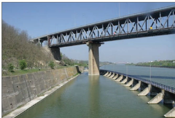
Fig. 10: Port așteptare amonte la ecluza Cernavodă. Susținerea malului și zona de racordare la ape mari ale Dunării
