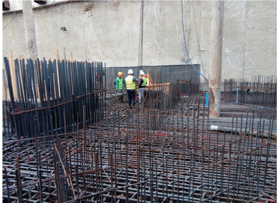
Fig. 5: Armare radier și mustăți pereți infrastructură
