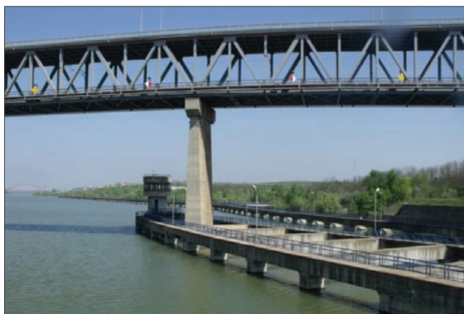
Fig. 9: Port așteptare amonte la ecluza Cernavodă. Mol central. Vedere dinspre ecluză la ape mari ale Dunării
