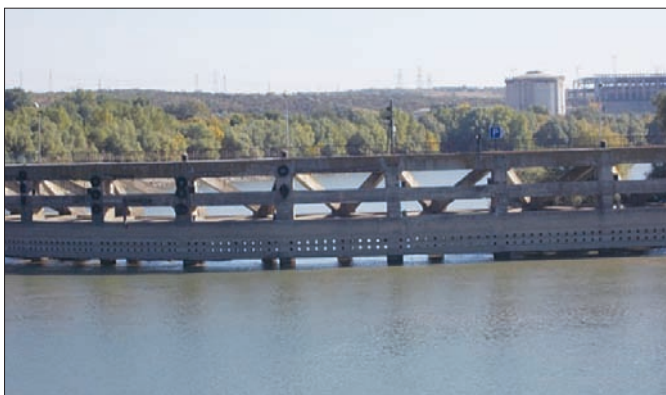
Fig. 4: Port așteptare amonte la ecluza Cernavodă. Zona de acostare văzută dinspre canal la ape mici ale Dunării
