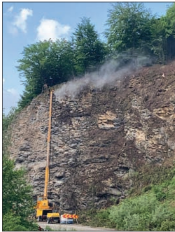
Foto 2: Realizarea ancorajelor la înălțime premergător instalării sistemului activ Tecco® G65/3
