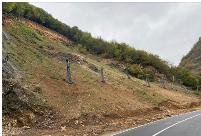
Foto 4: Instalarea montanților barierei RXE-1000, montanți cu plasa preasamblată
