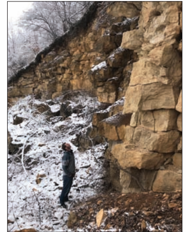
Foto 1: Zona-sursă pentru căderile de blocuri de rocă
