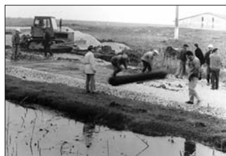
Fig. 2 Pânză formată de geogriile și balast/piatră spartă
