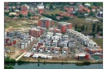
Fig. 3: Ansamblul rezidențial Green Lake Residence
