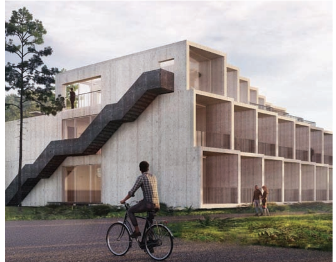
Extindere hotel GSH, Danemarca, 3XN / Bilanț negativ de carbon pe durata ciclului de viață, absorbind mai mult carbon decât consumă. Va utiliza elemente de proiectare pasivă și va fi construit din CLT.
