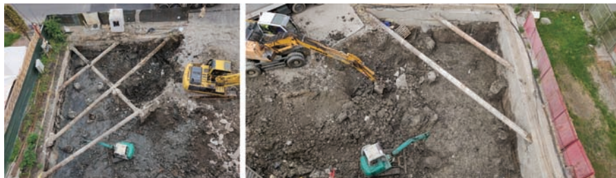
Fig. 10: Execuția excavației și a radierului pentru zona de birouri
