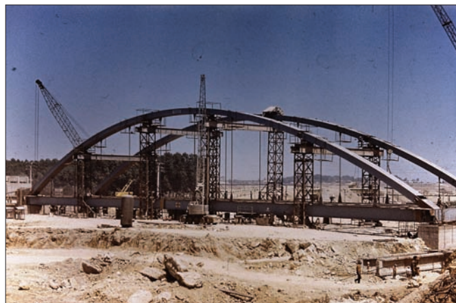
Fig. 45a: Aspect de la asamblarea tablierului metalic tip Langer al podului peste canalul Poarta Albă - Midia, Năvodari de la Ovidiu
