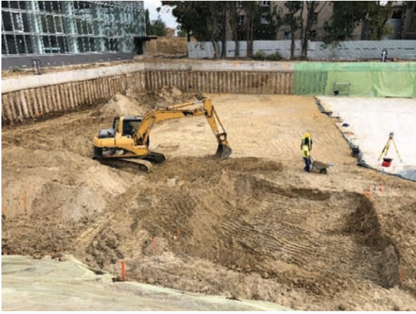
Fig. 5: Execuție excavație adâncă
