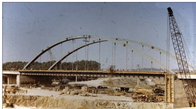
Fig. 45b: Aspect de la ridicarea tablierului metalic al podului de la Ovidiu prin metoda sub-betonării
