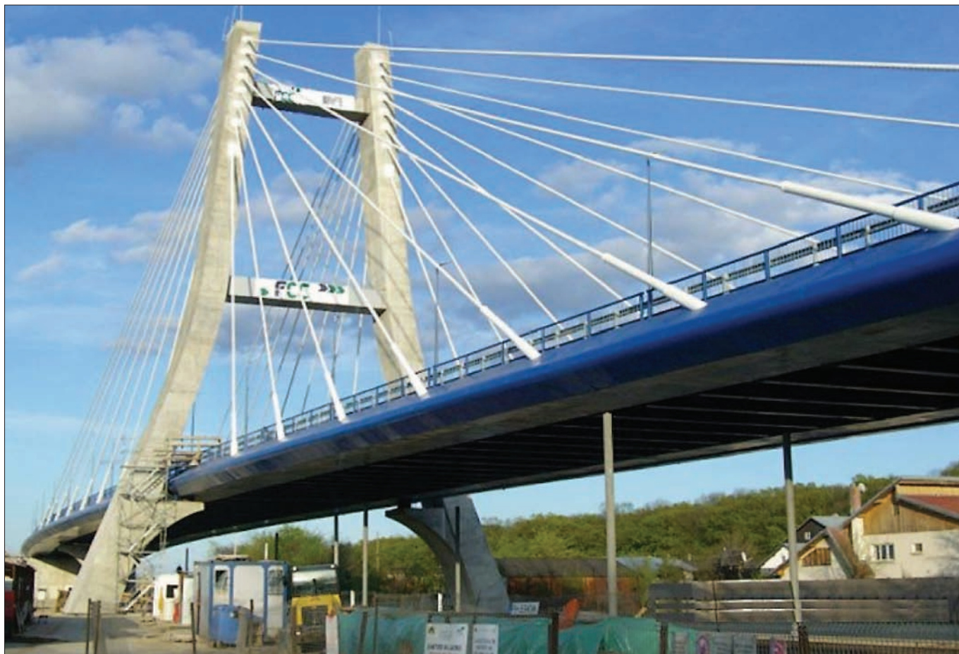
Fig. 49: Aspectul pasajului superior hobanat peste linia de centură a municipiului București la Otopeni
