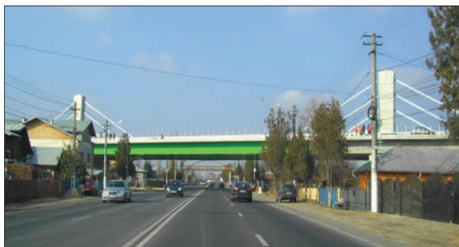
Fig. 50: Pasajul hobanat pe autostrada A2 București - Ploiești peste DN1 la Bărcănești, jud. Prahova
