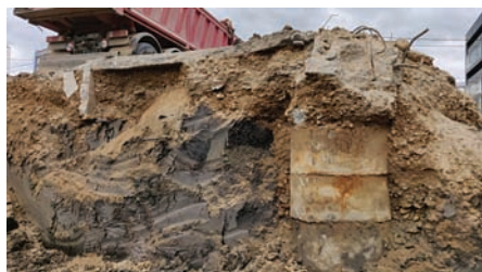
Fig. 11: Chesoane găsite pe amplasament la realizarea săpăturilor
