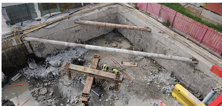
Fig. 8: Încercarea pe piloți pentru zona de birouri
