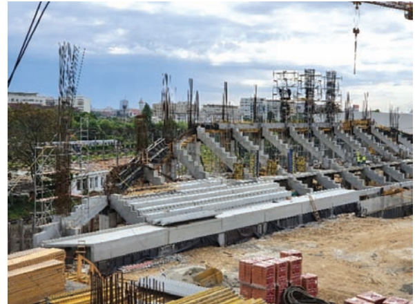
Fig. 7: Montaj grinzi și gradene prefabricate
