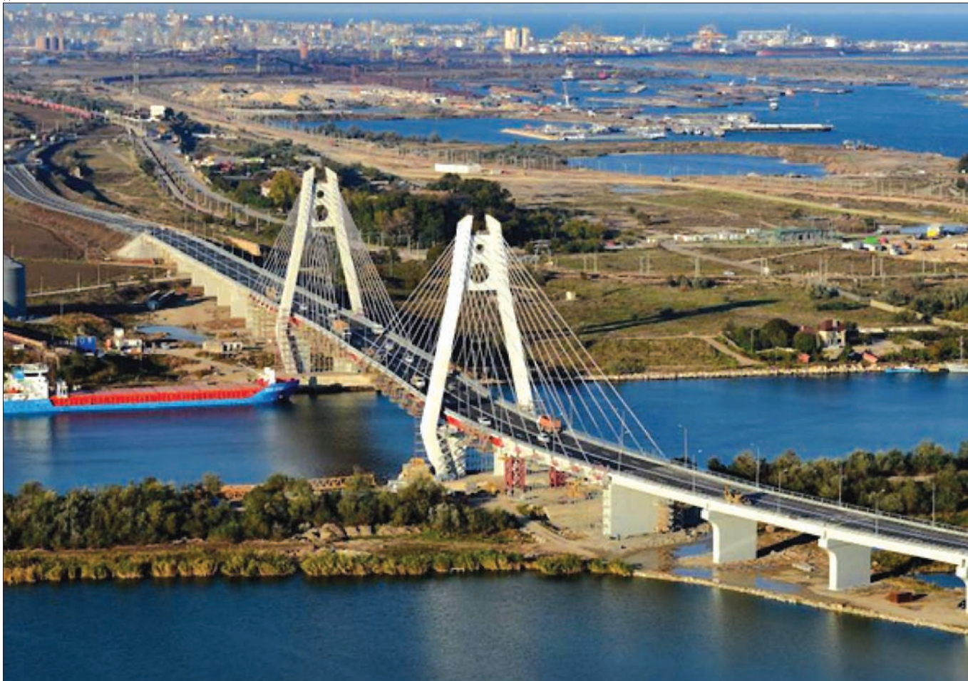
Fig. 46: Aspectul podului peste canalul Dunăre - Marea Neagră în zona portului Constanța-Sud Agigea
