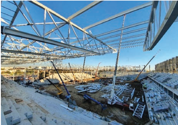
Fig. 9: Montaj structural acoperiș metalic
