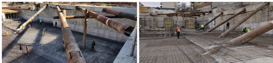
Fig. 4: Incinta de pereți mulați și sistemul de sprijinire cu șpraițuri
