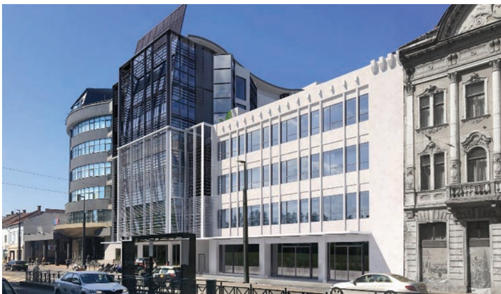
Modernizare clădiri, UTCN
