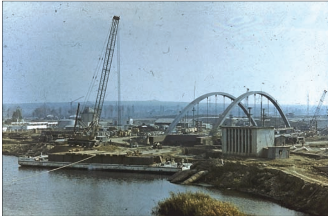
Fig. 34: Aspectul pregătirii operației de lansare a tablierului metalic peste albia canalului
