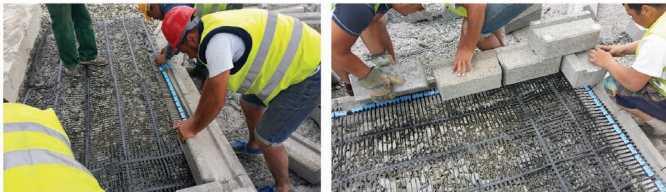
Instalare simplă, manuală, fără macarale sau sprijiniri
