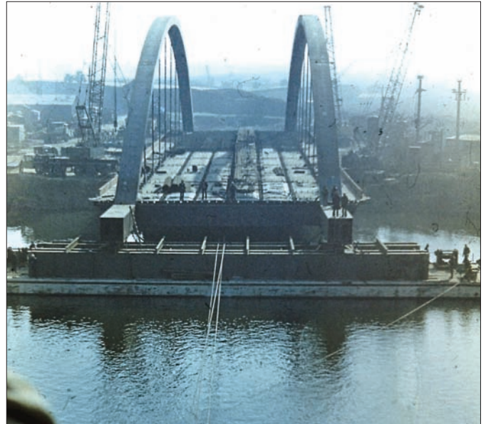
Fig. 37: Aspect din timpul lansării tablierului peste canal
