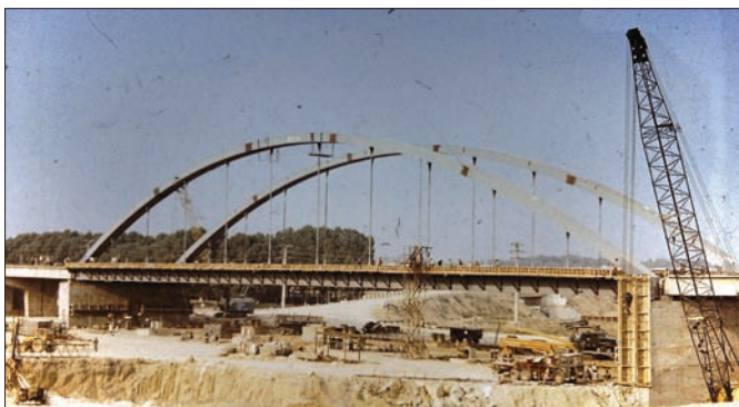
Fig. 40: Aspect de la ridicarea tablierului tip Langer cu vinciuri hidraulice
