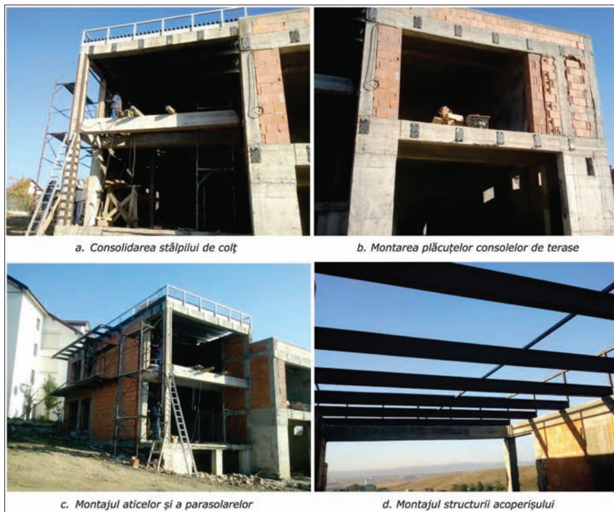
Fig. 6: Detalii despre intervențiile structurale
