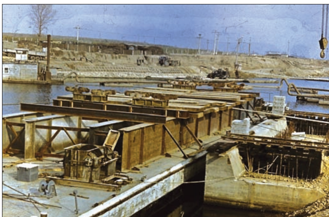
Fig. 36: Aspectul amenajării gabarei plutitoare în vederea lansării tablierului metalic peste canal
