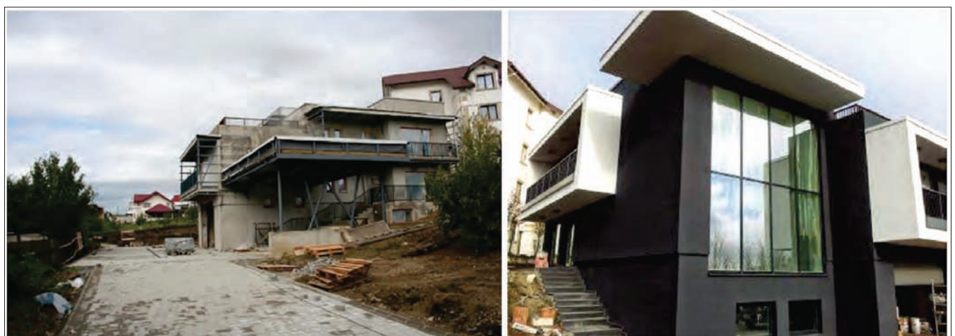
Fig. 5: Aspectul clădirii aproape de finalizare și clădirea în stare finisată
