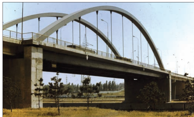
Fig. 42: Vedere generală pod peste canalul Poarta Albă - Midia, Năvodari la Poarta Albă
