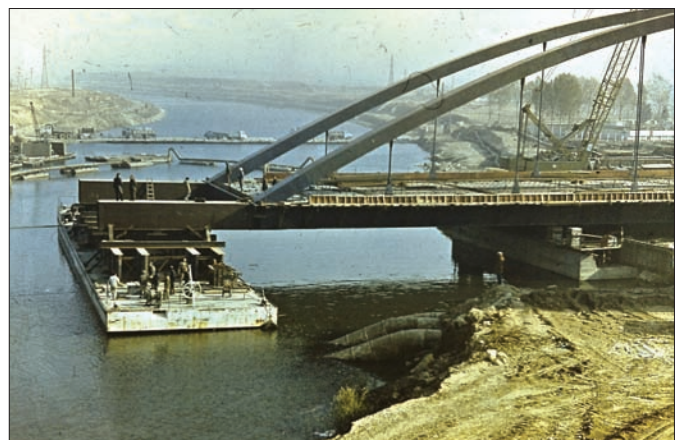
Fig. 38: Aspect din timpul lansării tablierului tip Langer peste șenaul canalului văzut de pe podul paralel de cale ferată
