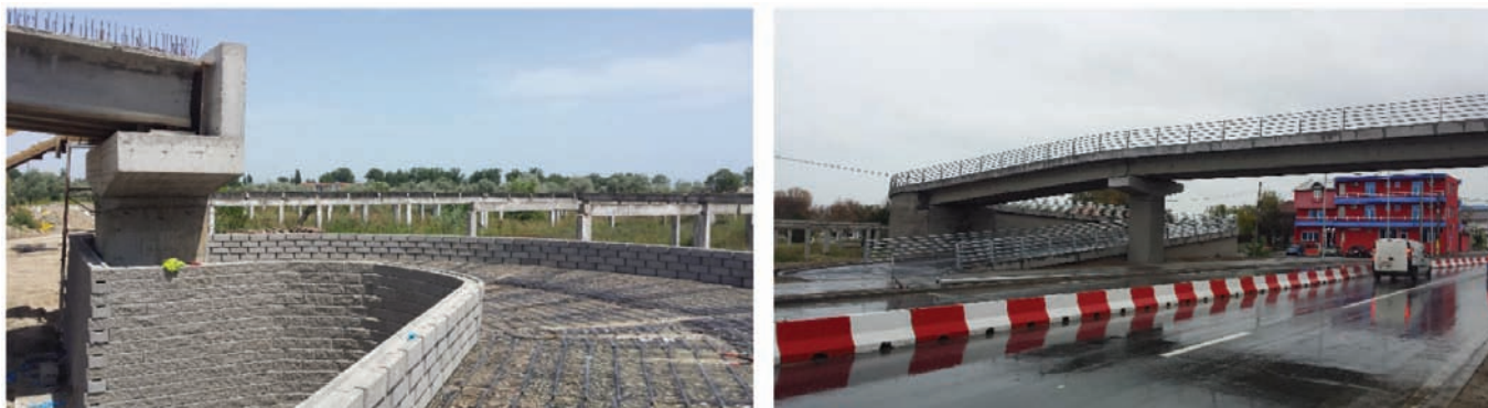
Pasaj Năvodari - executat cu Sistemul TENSAR® TW1 (2016)
