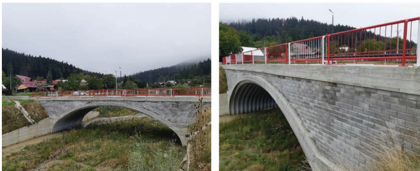
Pod SOLCA, jud. Suceava - executat cu Sistemul TENSAR® TW1 (2019)
