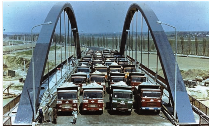
Fig. 41: Aspect de la testarea „in situ” a podului principal cu convoaiele de calcul
