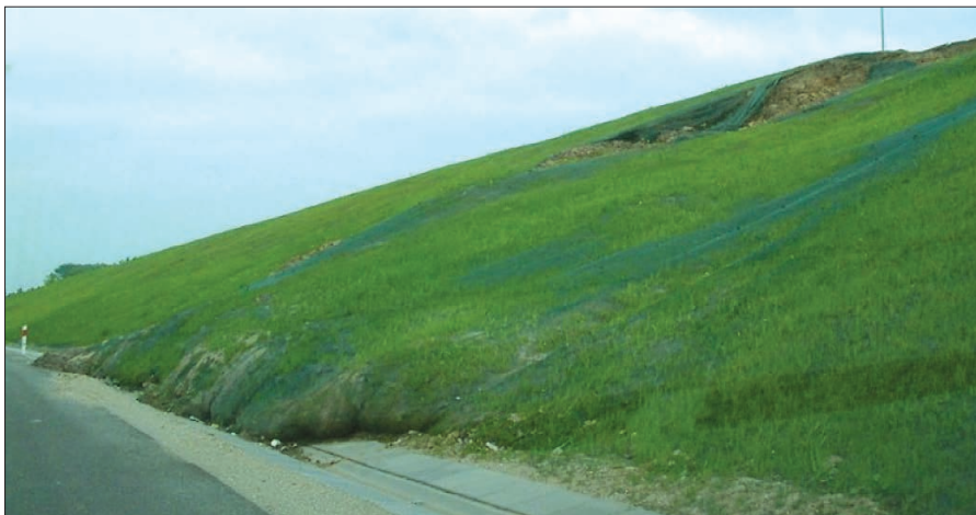
Foto 1: Cedarea unui taluz cu o înclinare de aproximativ 25°, asigurat cu geotextil/rețea de control al eroziunii pentru revegetare și fără țintuire
