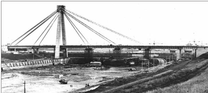
Fig. 24: Aspect din execuție. Suportii provizorii la montaj
