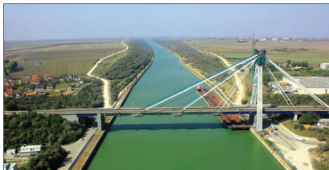
Fig. 28: Aspectul podului Agigea în perioada schimbării hobanelor
