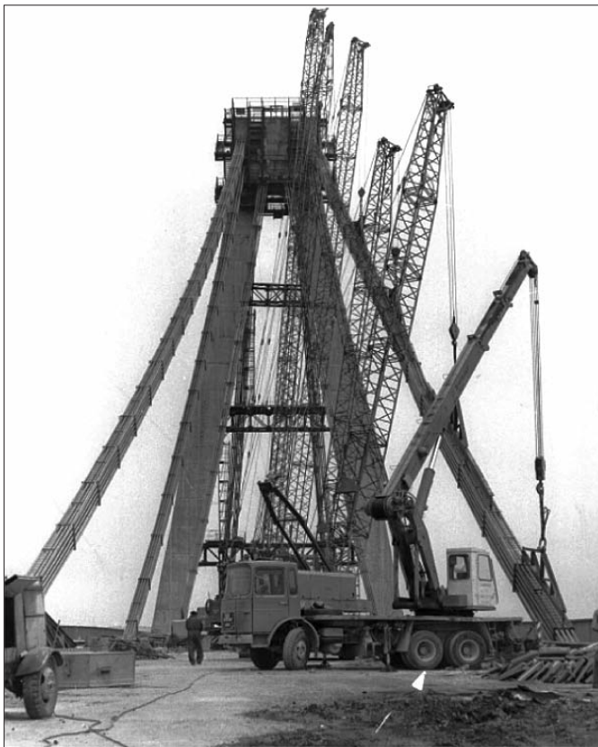
Fig. 25: Aspect din execuție. Montarea hobanelor
