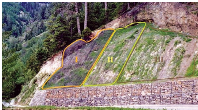
Foto 3: Zonle de testare pentru evaluarea rețelei antierozionale
