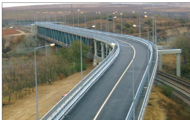
Fig. 1: Aspectul podului combinat de cale ferată și șosea de la Cernavodă
