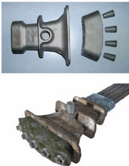
Fig. 5: Ancoraj capăt activ – zonă de tragere a fiecărui tendon pentru precomprimarea plăcii
