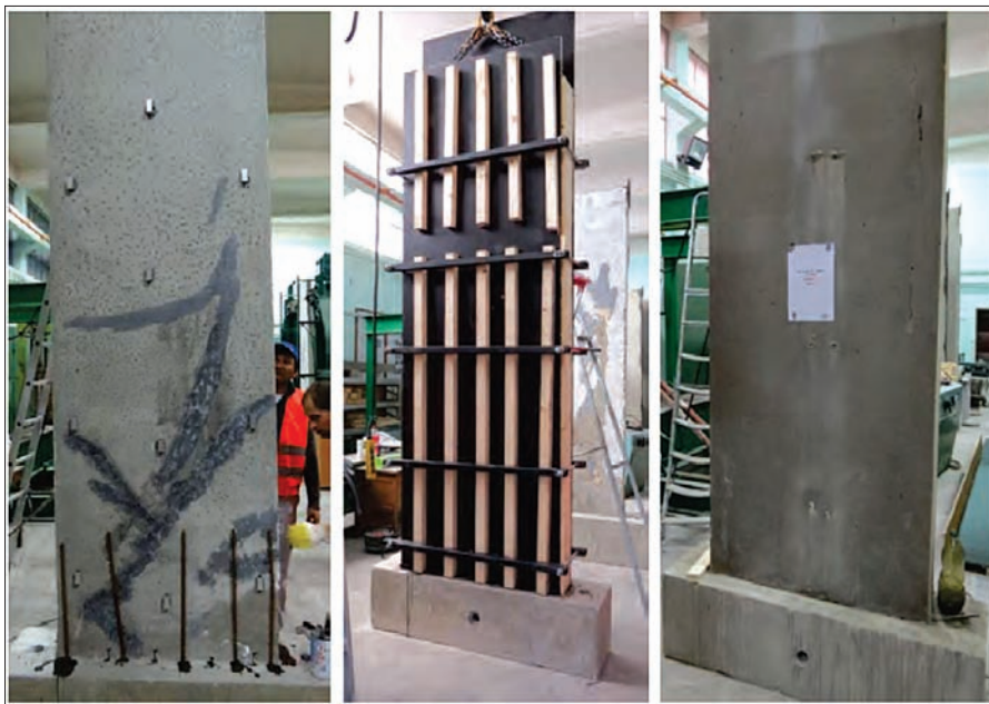
Fig. 11: Consolidarea speciemenelor - aplicarea ancorajelor la baza pereților și a distanțierilor metalici pe suprafața pereților, poziționarea cofrajului meșteșugăresc pentru aplicarea în sens gravitațional a mortarului propus pentru consolidarea elementelor
