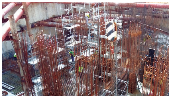
Fig. 3: Armare pereți infrastructură
