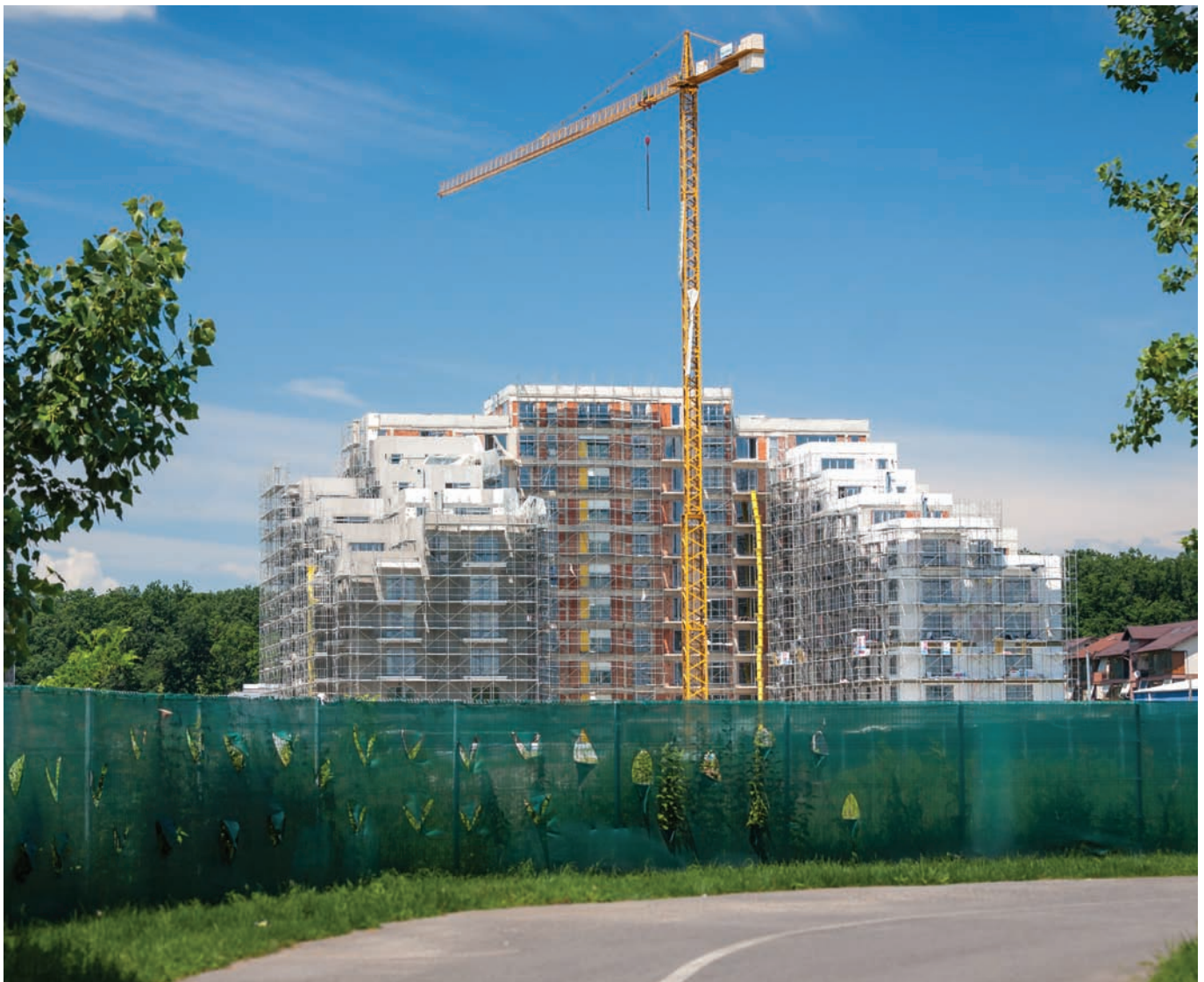
Complexul rezidențial ARBO (în construcție)
