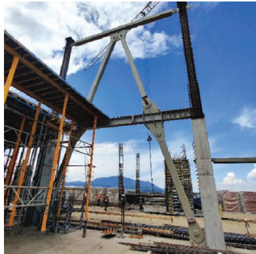
Fig. 8: Cadru contravântuit - Sistem de tip „V-inversat”
