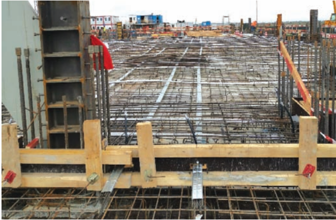
Fig. 4: Amplasare toroane de post-tensionare
