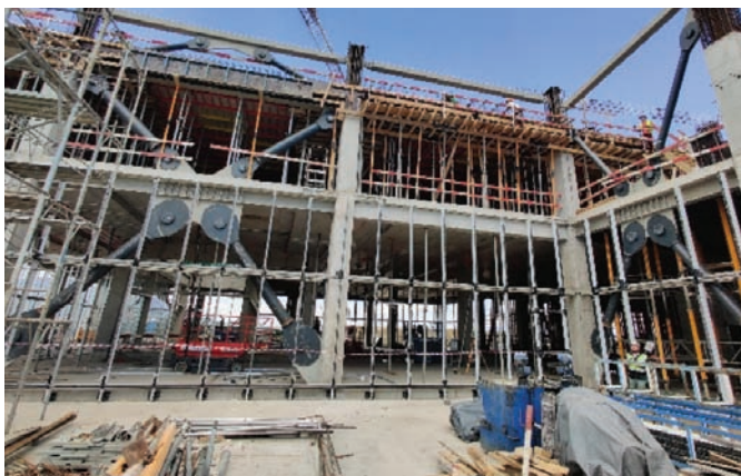
Fig. 7: Cadru contravântuit - Sistem în „X”
