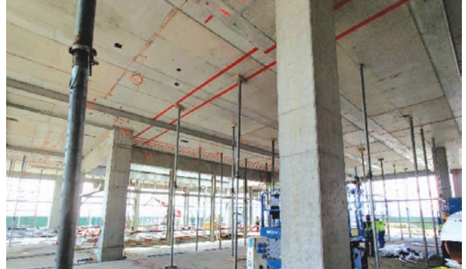
Fig. 5: Zonă de placă cu deschideri de 9 m pe o direcție și 14.40 m pe direcția perpendiculară (cu roșu sunt marcate toroanele de post-tensionare)
