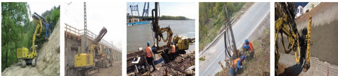
Lucrări de consolidare infrastructură rutieră, feroviară și navală; ancoraje sisteme de protecție versanți și excavații
