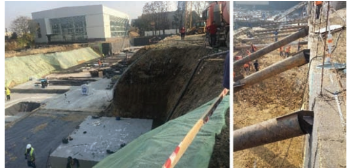
Fig. 8: Imagini din timpul execuției lucrărilor aferente excavației adânci
