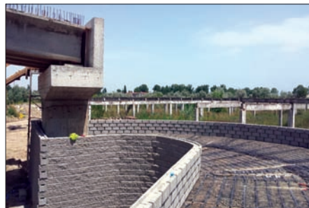
Cofrarea zidului de sprijin din beton versus construirea unui zid de pământ armat
