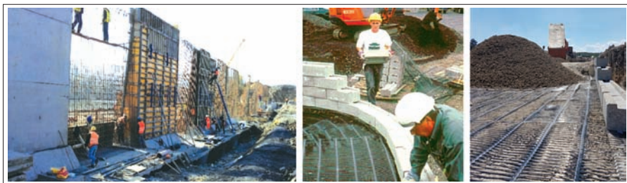
Cofrarea zidului de sprijin din beton versus construirea unui zid de pământ armat
