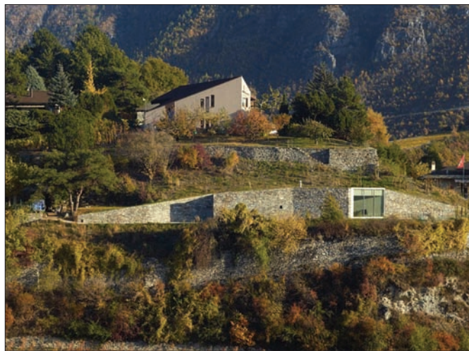
Fig. 27: Pavilion la Sierre, Elveția / Bassicarella Architectes - mimetism, textură
