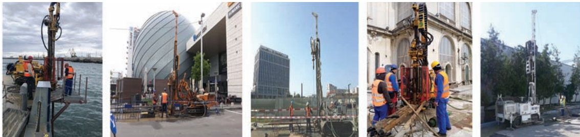
Cercetare geologo-tehnică, geotehnică și hidrogeologică; foraje pentru cercetare seismică și teste de răspuns termic
