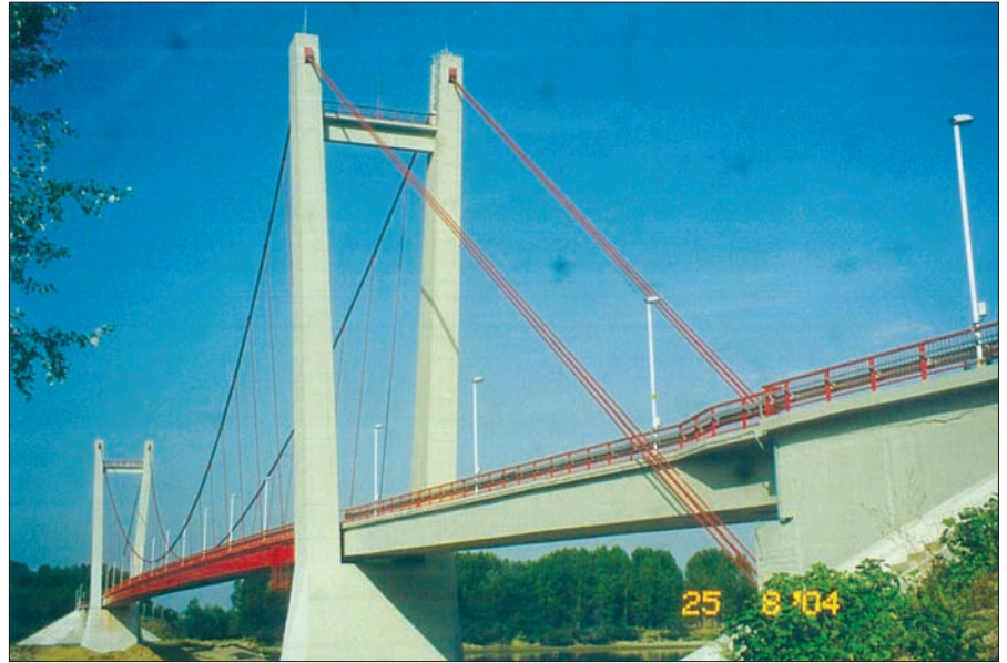
Fig. 7: Podul Gogoșu. Vedere generală
