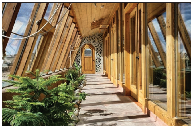
Fig. 9: Sera unui "earthship" cu mecanismele de captare a radiației solare
