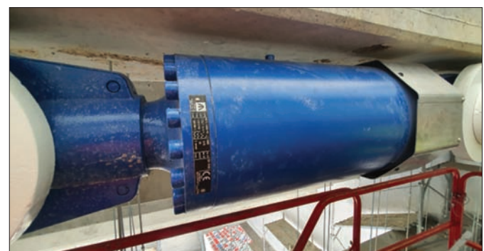
Fig. 11: Dispozitiv tip „lock-up” - furnizor Maurer
