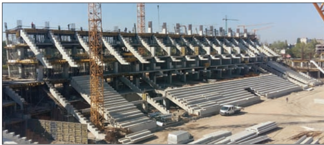
Fig. 7: Montaj prefabricate
