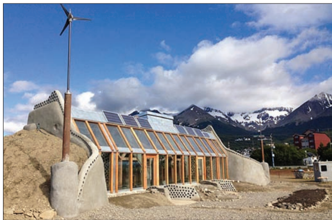
Fig. 8: Earthship construit în Ushuaia, Argentina / arh. Michael Reynolds
