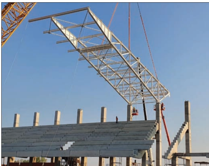
Fig. 13: Montaj fermă metalică acoperiș
