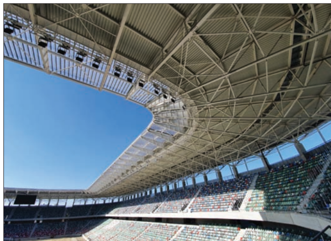
Fig. 14: Structură acoperiș metalic
