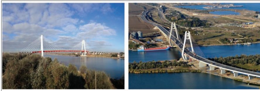
Fig. 20: Aspecte ale podului hobanat peste Canalul Dunăre - Marea Neagră la Agigea. a) Vedere laterală, b) Vedere aeriană
