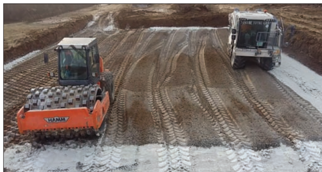
Fig. 3: Îmbunătățire teren de fundare în execuție
