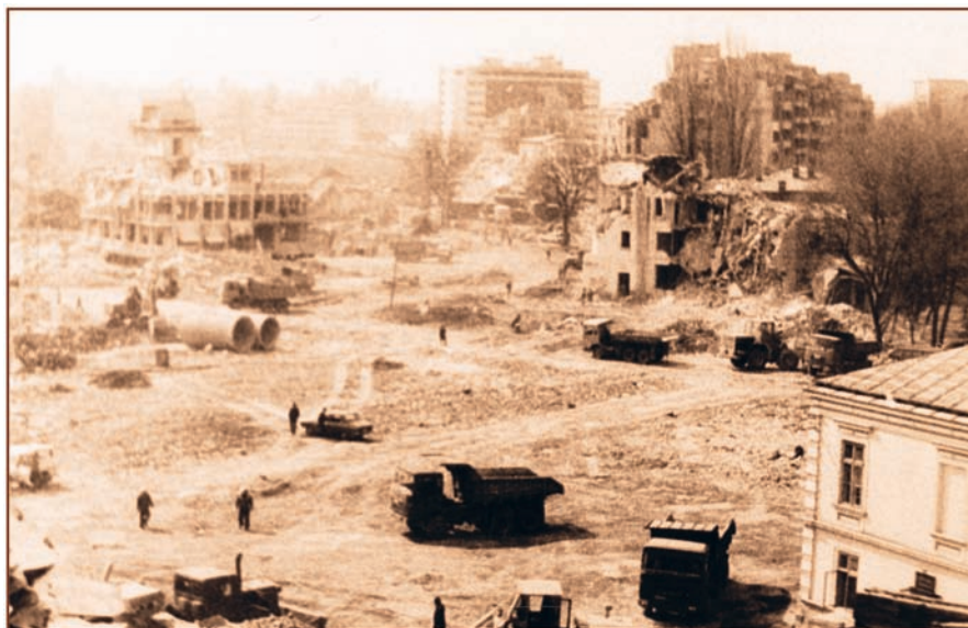
Imagine de la demolarea Spitalului Brâncovenesc
