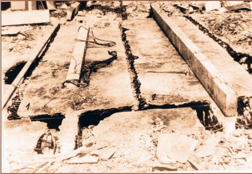
Imagine de la demolarea Spitalului Brâncovenesc
