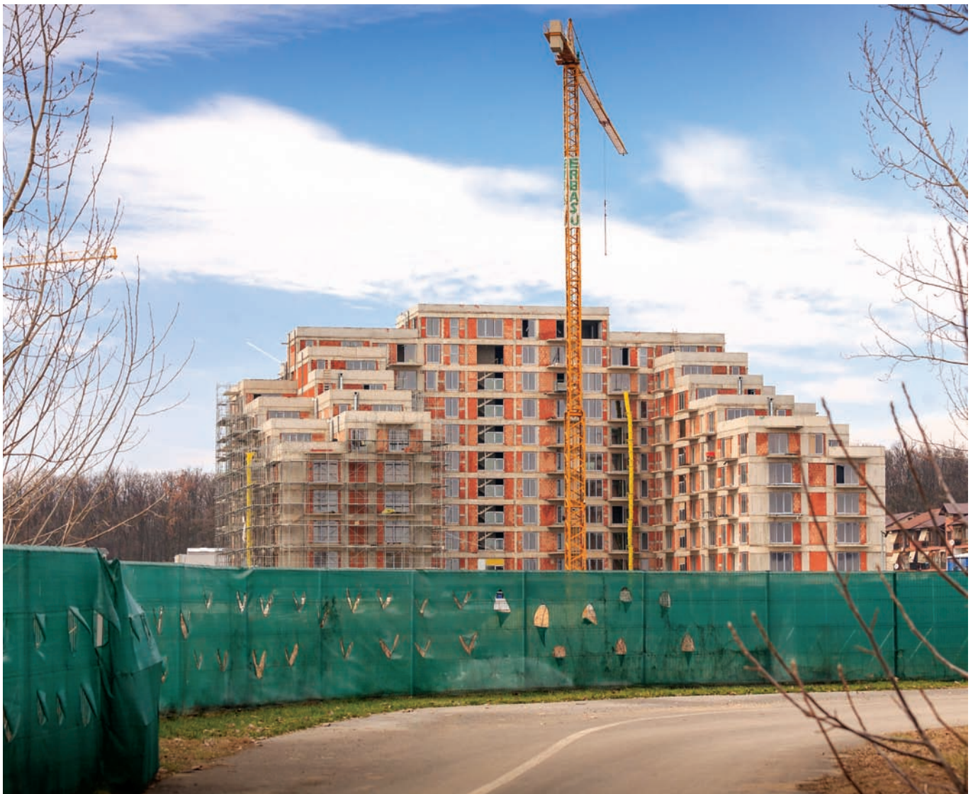
Complexul rezidențial ARBO (în construcție)
