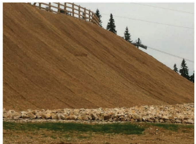
Lac artificial pe Domeniul Schiabil Poiana Brașov, România - proiectul a inclus stabilizarea malurilor cu ajutorul GREENFIX® Covamat
