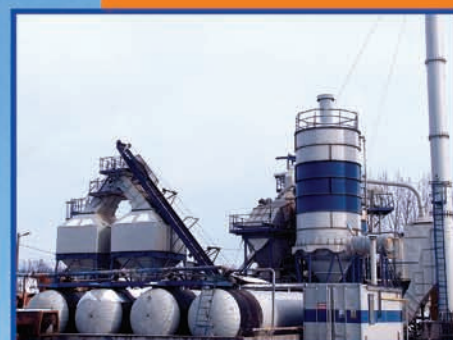
STATIE MIXTURI ASFALTICE
