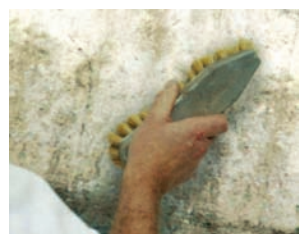
1. Curățire mecanică pe suport umed
