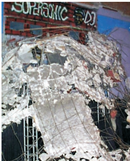
Foto 4: Aspect al tavanului prăbușit; se observă plasa de susținere.
