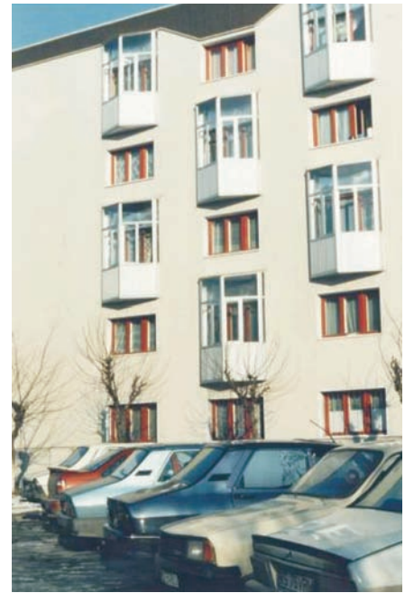
Fig. 2 : Un pas în direcția dezvoltării durabile: căminul studențesc T14 din Iași, clădire realizată din panouri mari prefabricate, după efectuarea lucrărilor de modernizare prin consolidarea structurii, îmbunătățirea protecției termice și montarea de bovindouri cu rol de seră.
