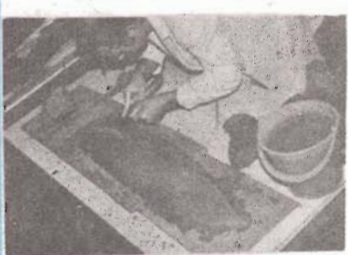
3, 4, 5. — După umplere grosieră, se netezește cu șpaclul ud la nivelul coastelor.
