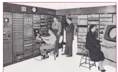
⇒ Primul calculator cu afișaj electronic și grafică vectorială - MIT Whirlwind
