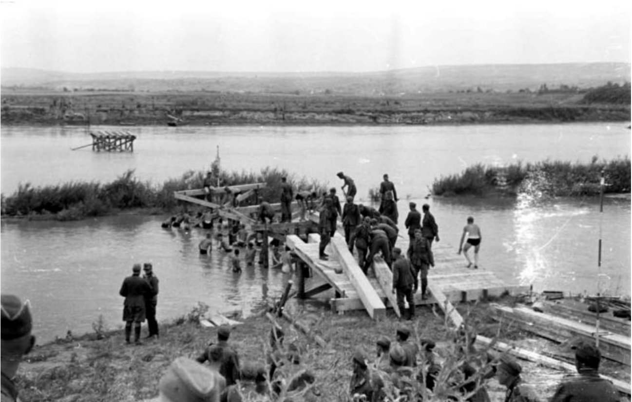
Construcția podului peste Prut (1 iulie 1941)
