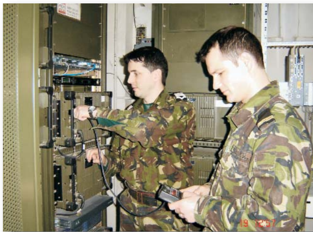
▲ 2008 – instrucție de specialitate (comutator CD 141 – de la 60 până la 960 abonați)
