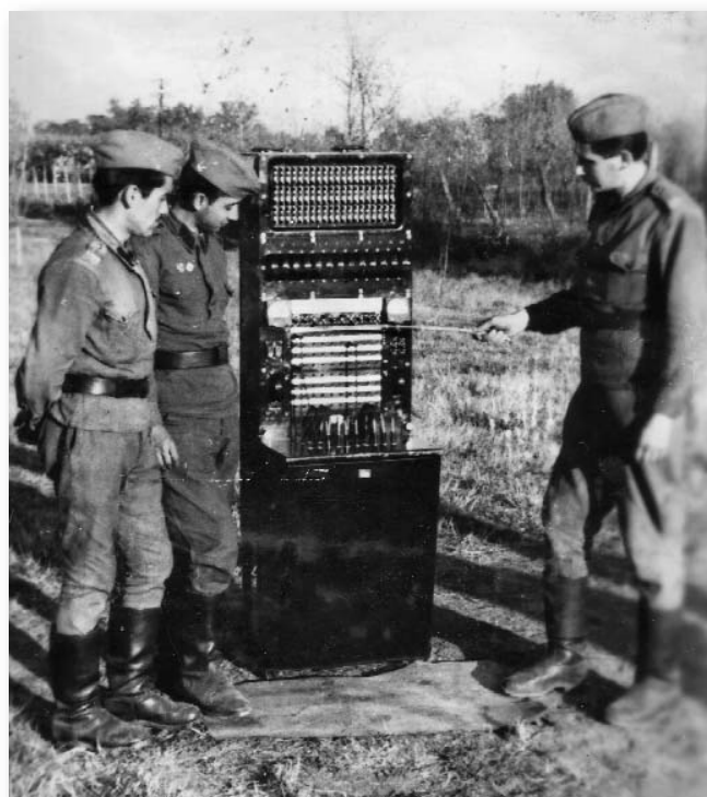
▲ 1958 – instrucție de specialitate (centrala telefonică cu 30 numere)
