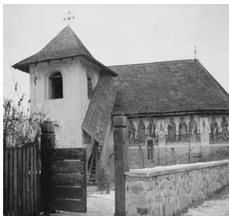
Fig. 35 Biserica „Adormirea Maicii Domnului” - Olari, Curtea de Argeș, după restaurare, 1977 (arh. Ștefan Mănciulescu)
