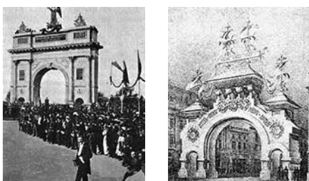
Fig. 2 Stânga Etapa I / 1878, Războiul de Independență – construcție temporară din lemn; Dreapta Etapa II / 1919, după planurile arh. Constantin Nănescu (Virgiliu Z. Theodorescu, Arcul de Triumf )
