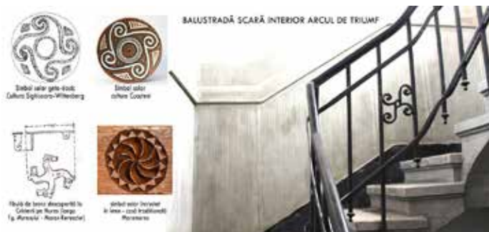
Fig. 16 Elemente ornamentale balustradă fier forjat și corespondente în semiotica din spațiul carpatic. În imagine se poate observa și paramentul interior din similpiatră – înainte de acoperirea sa cu tencuială (Credo Design, 2017)
