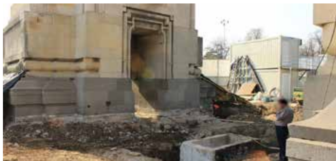
Fig. 17 Lucrări de decopertare ale pavamentului și săpături în zona fundațiilor (Credo Design, 2013)
