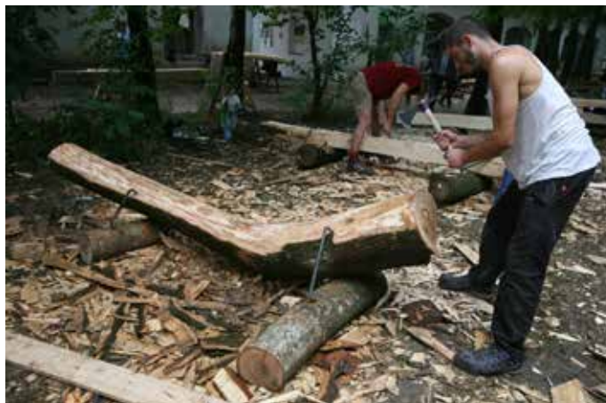
Fig. 12 Dulgheri și ucenici din 5 țări lucrează la transformarea materiei prime în subansambluri ale fermelor, Țibănești, 2017 (Alexandra Mihailciuc)
