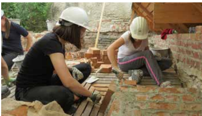
Fig. 9 Reconstruirea unei bolți deasupra grajdului baroc în cadrul Cursului de specializare în reabilitarea patrimoniului construit (Transylvania Trust, 2015)
