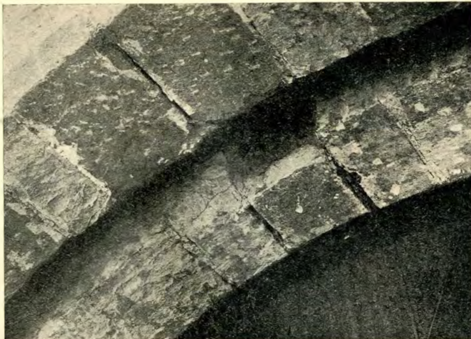
Fig. 4. — Clopotnița mănăstirii Sfântul Gheorghe din Suceava. Cheia arcadei dela intrare, după înlăturarea tencuelilor în 1939. Se vede șanțul ușilor culisante. Clișeul autorului
