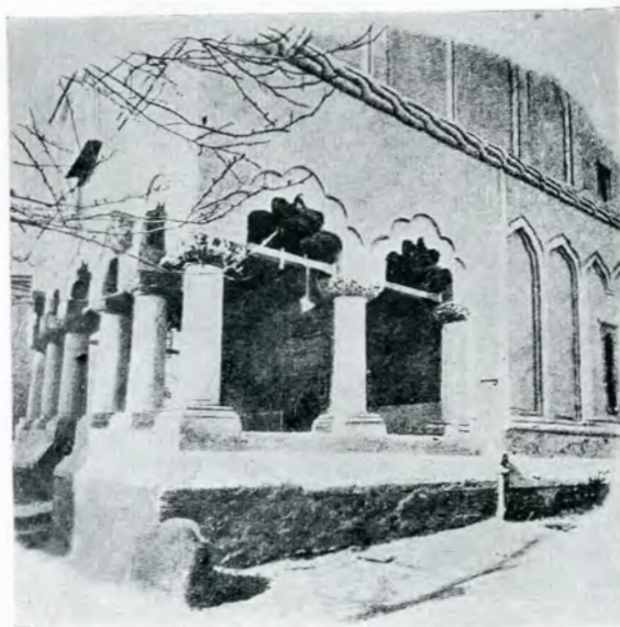
Fig. 232. — Détail du porche
