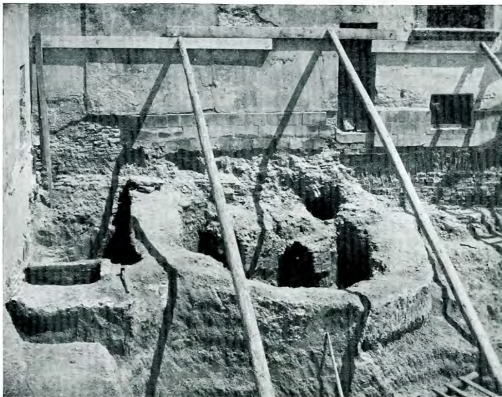
Fig. 1. — Curtea Veche din București. Ruinele cuptorului subteran al băii.
