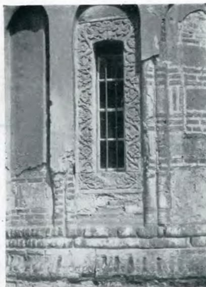
Fig. 369. — Fenêtre à Marcutza 1730
