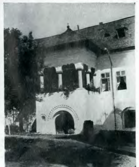
Fig. 248. — Belvedere au monastère de Dintrun Lemn vers 1700
