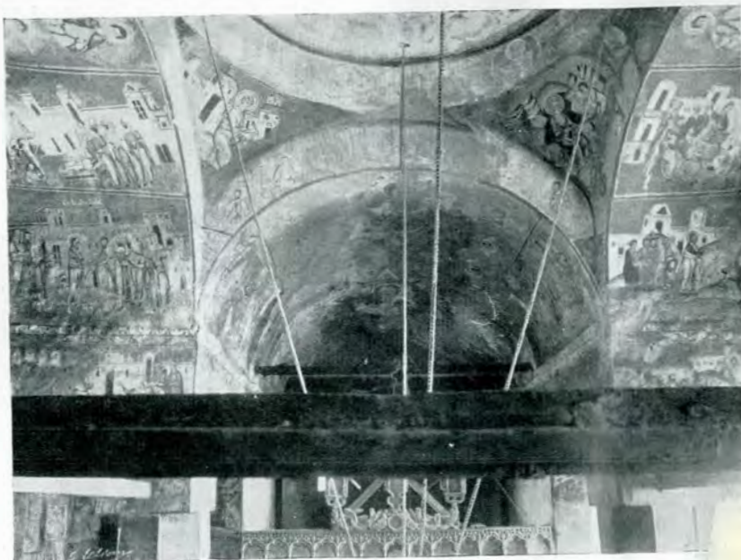
Fig. 146. — Voûtes peintes à l'église princière de Târgoviște
