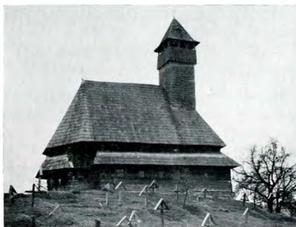
Fig. 246. — Biserica din Apșa-de-Mijloc. Vedere laterală.
