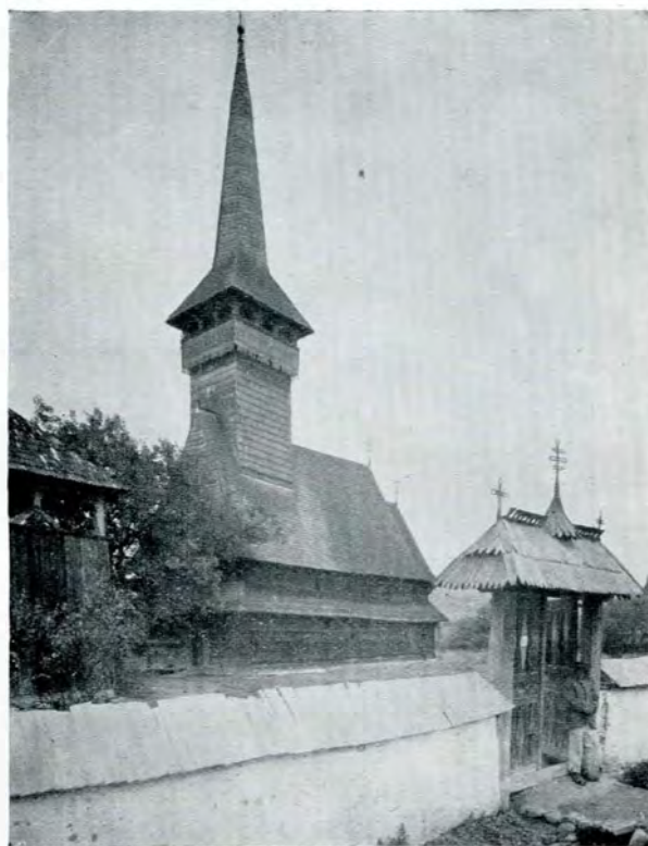
Fig. 172. — Biserica din Cuhea. Vedere laterală.
