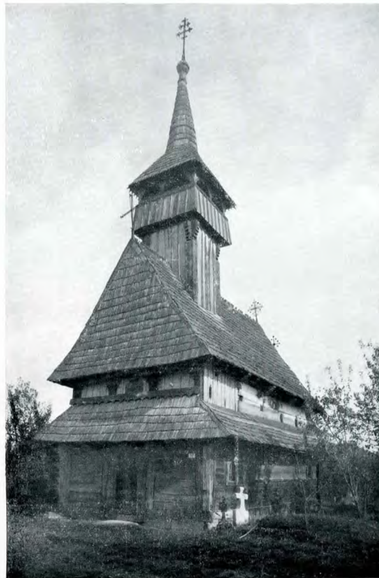
Fig. 96. — Biserica din Bârsana. Vedere din spre Sud-Vest.
