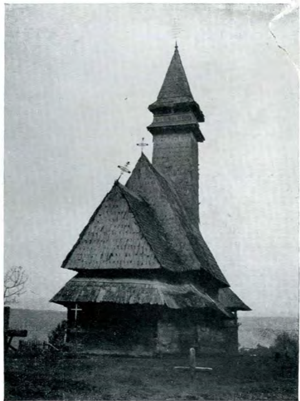
Fig. 253. — Biserica din Apșa-de-Mijloc. Vedere din spre Nord-Est.
