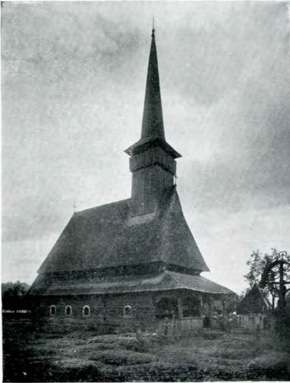
Fig. 150. — Biserica din Șieu. Vedere din spre Nord-Vest.
