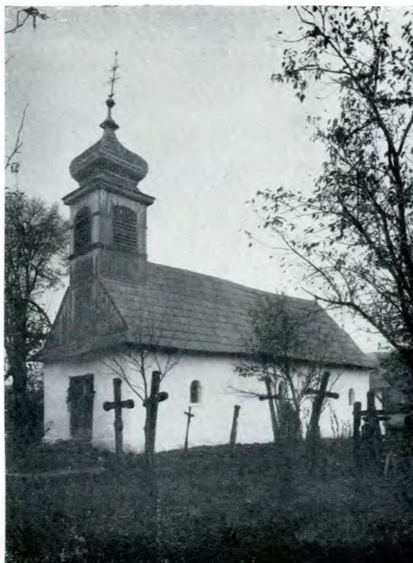
Fig. 135. — Biserica din Strâmtura. Vedere din spre Sud-Vest.
