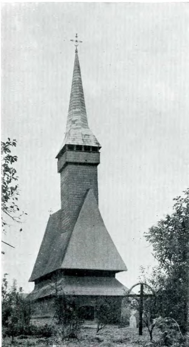
Fig. 191. — Biserica din vale din Ieud. Vedere.
