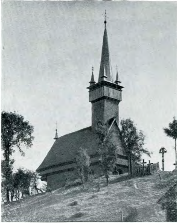
Fig. 241. — Biserica din Apșa-de-Jos. Vedere din spre Nord-Vest.
