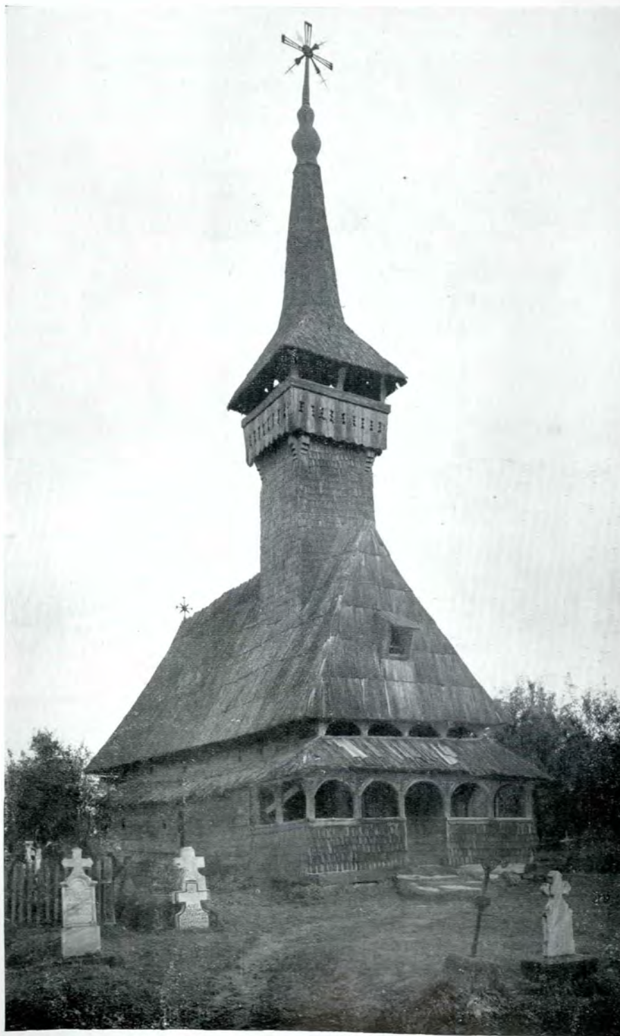
Fig. 90. — Biserica din Oncești. Vedere din spre Sud-Est.
