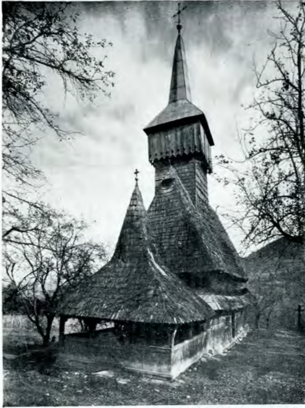
Fig. 118. — Biserica din Văleni. Vedere din față.
