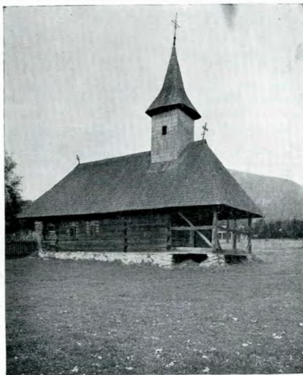
Fig. 224. — Biserica mănăstirii Moisei. Vedere din spre Nord-Vest.
