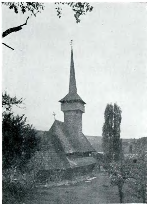
Fig. 227. — Biserica din Borșa. Vedere din spre Nord-Est.
