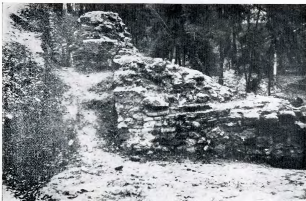
Fig. 2. — Zidul centurii exterioare pe panta de Est, privit de la Vest de turnul arcuit ; în față îngustarea grosimii lui, către turn ; în fund, la stânga, retragerea pe pantă a aceluiași zid spre sectorul nordic al centurii exterioare.
