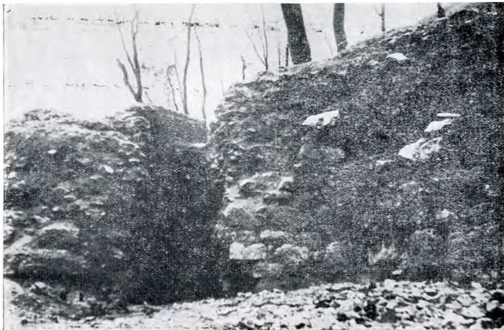
Fig. 4. — Spărtură la legătura dintre zidul estic al centurii exterioare și capătul nordic al turnului arcuit; pârte de construcție recentă, în spatelc turnului
