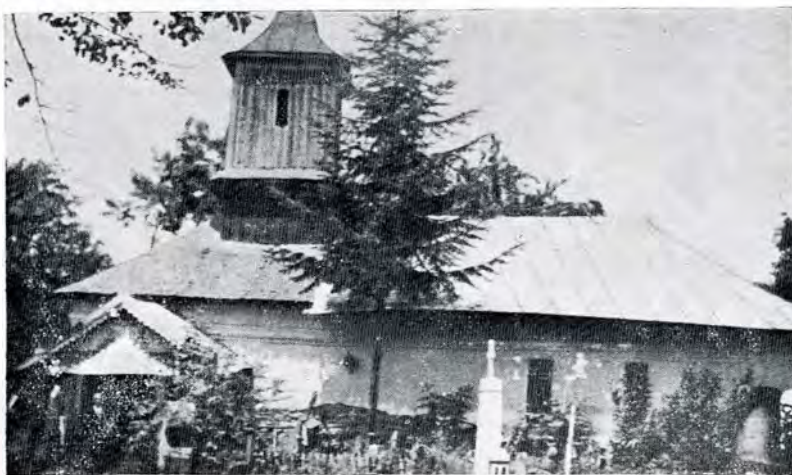
Biserica veche Cuv. Paraschiva din Scorțeni, înainte de reparație.
