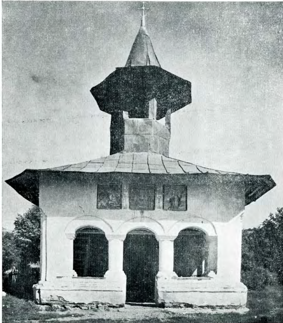
Fig. 2. – Biserica din Boldești-Prahova. Fațada.
