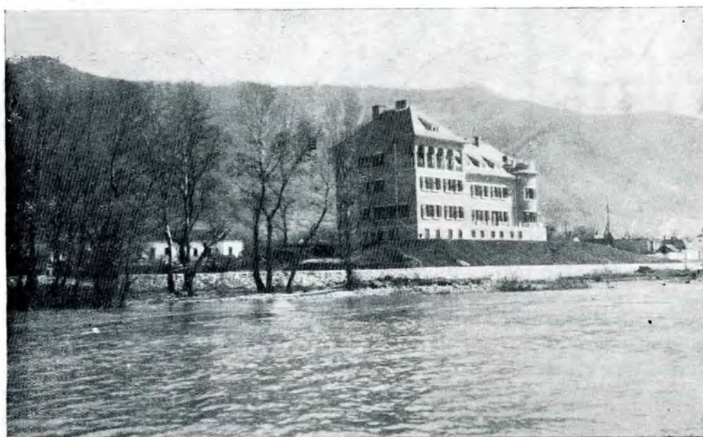
Fig. 21. — Palatul Administrației Porților-de-Fier, peste ruinele castrului Transdierna; la dreapta alte construcții, despărțite de prin pârâul Techia.
