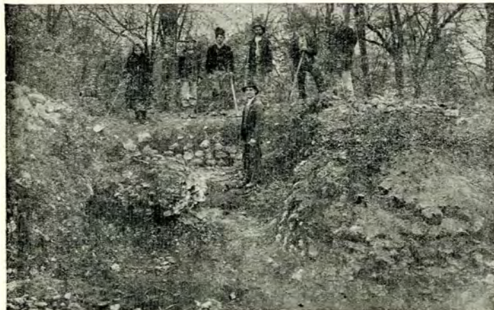
Fig. 6. – Fața zidului estic al incintei interioare.
