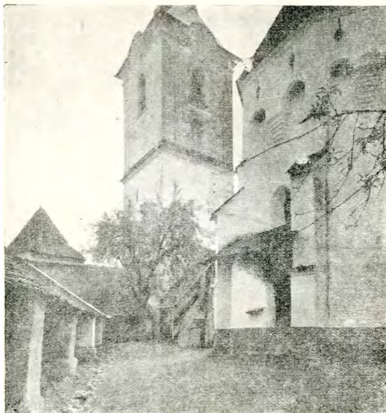
Fig. 7. - Biserica din Dărjiu. Locurile de unde se apărau.
