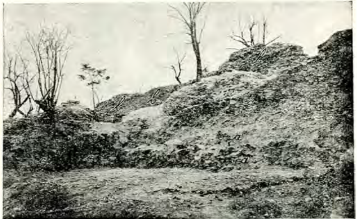
Fig. 13. — Zidul sudic al turnului de Sud-Est: a, parament și blocaj interior; b, zidul sudic al incintei interioare; c, prelungirea spre Sud a zidului vestic al turnului.
