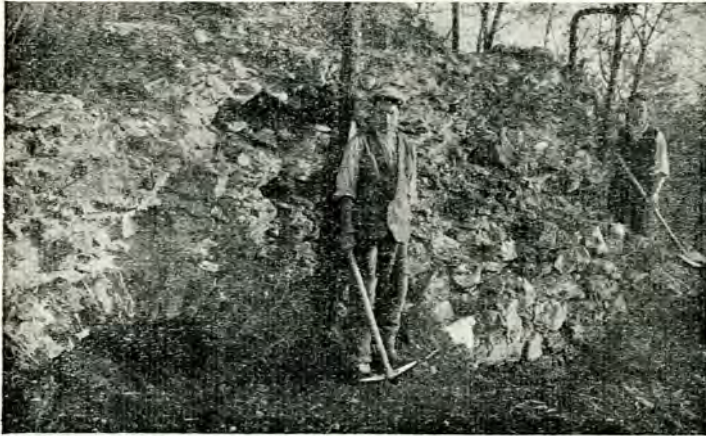
Fig. 10. — Pragul de sus boltit al porții din zidul sudic al incintei interioare, înainte de săpături.
