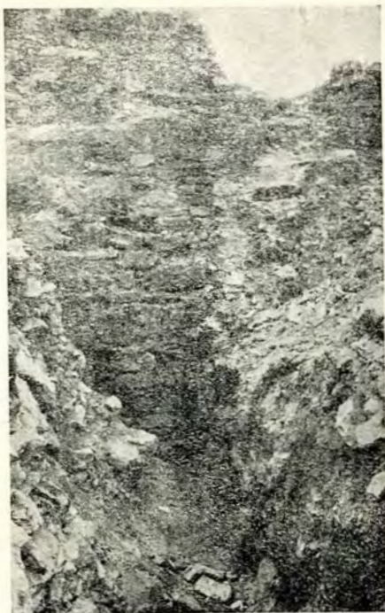
Fig. 14. – Zidul sudic al incintei interne (in fund); la dreapta zidul vestic al turnului de Sud-Est.
