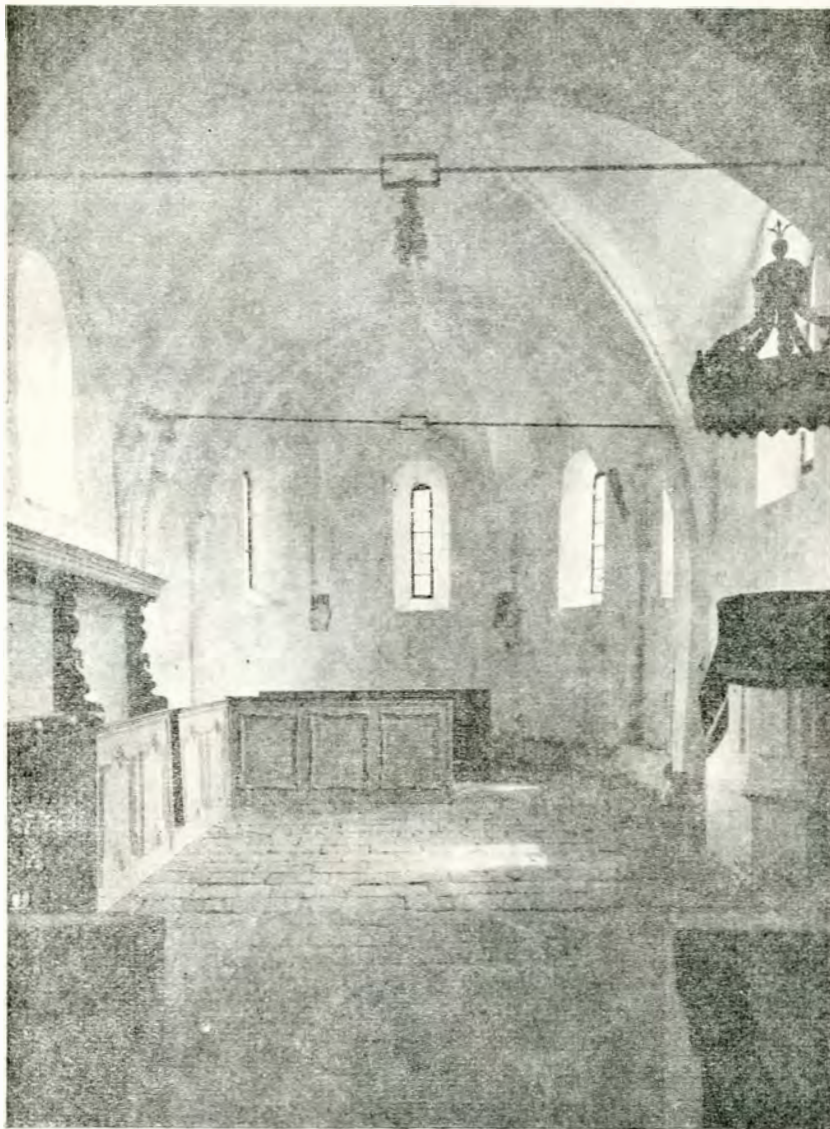
Fig. 4. — Biserica din Cricău, jud. Alba. Interior. Arcurile de piatră ale bolților. Pardoseala cu cărămizi romane.
