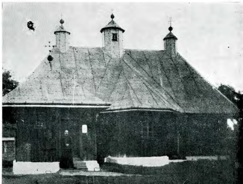
Fig. 10. — Biserica din com. Brăiești. Vedere din spre Nord.
