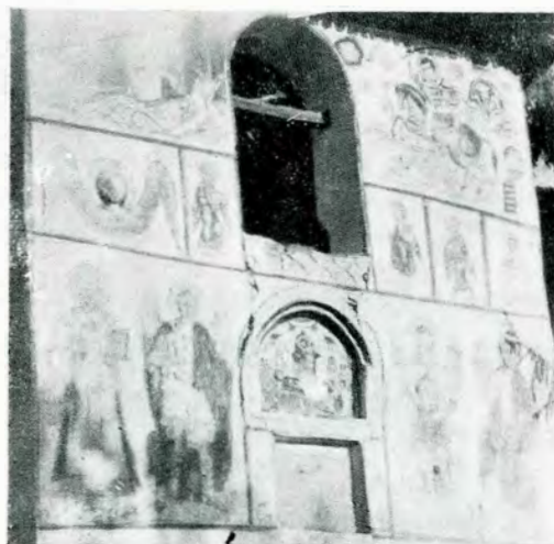
Fig. 5. — Pictura clopotniței bis. Grușetu din Costești-Vâlcea. Vedere spre Vest.
