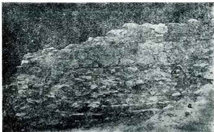
Fig. 6. — În latura sudică, în dreptul pronaosului: a, din elevația bisericii I, blocaj intern; b, paramentul bisericii a II-a.
