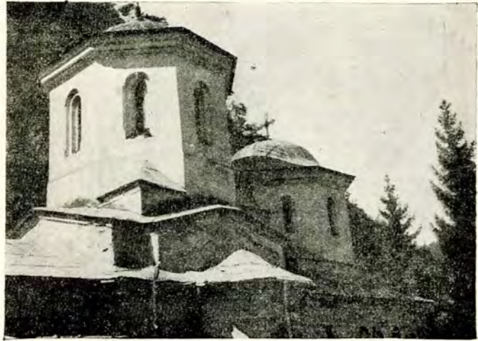
Fig. 6. — Vedere asupra turelor și a frontoanelor triunghiulare la baza celei de pe naos.
