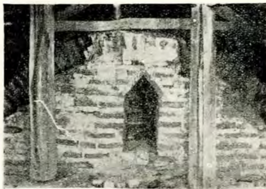
Fig. 8. — Biserica din Hârțiești: Detaliu din zidărie la fronton.
