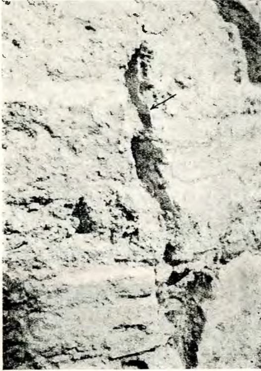
Fig. 7. — Tismana ; angle Sud-Ouest de l'abside méridionale.
