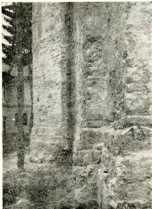
Fig. 7. -- Detaliul soclului. In 13 cărămidă zmălțuită.
