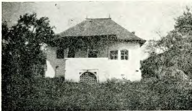
Fig. 3. — Casă de pe Valea Teleajenului.
