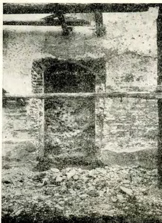
Fig. 8. — Ușa găsită pe latura nordică a pronaosului.
