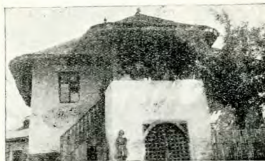
Fig. 5. — Casă de pe Valea Teleajenului.
