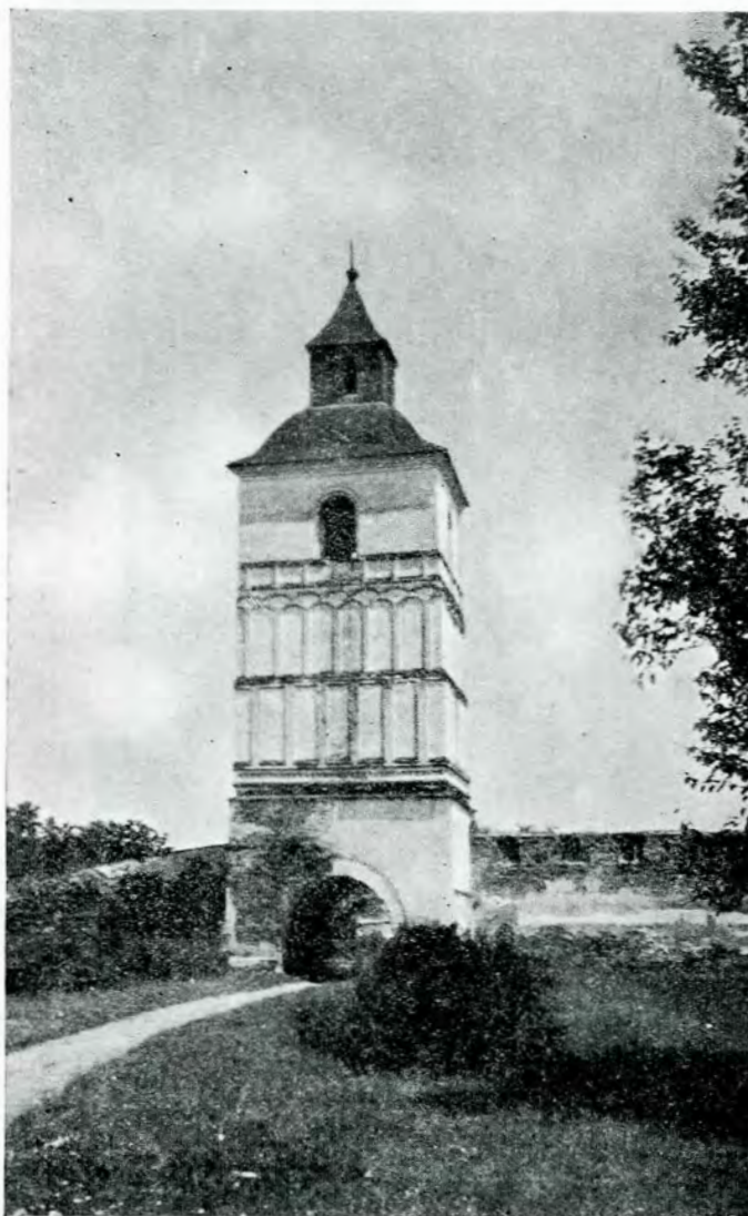
Fig. 12. — Mănăstirea Strehaia, Mehedinți. Vederea clopotniței.
