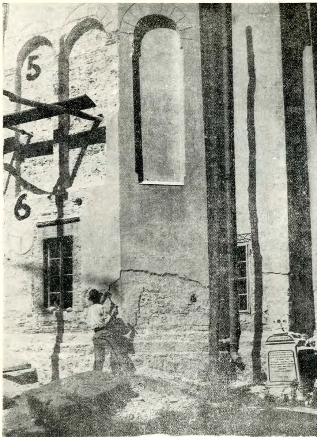
Fig. 19. — Detaliu din altar, după cojire și înainte de cojirea paramentelor. (5 și 6 brăie orizontale de cărămidă.)
