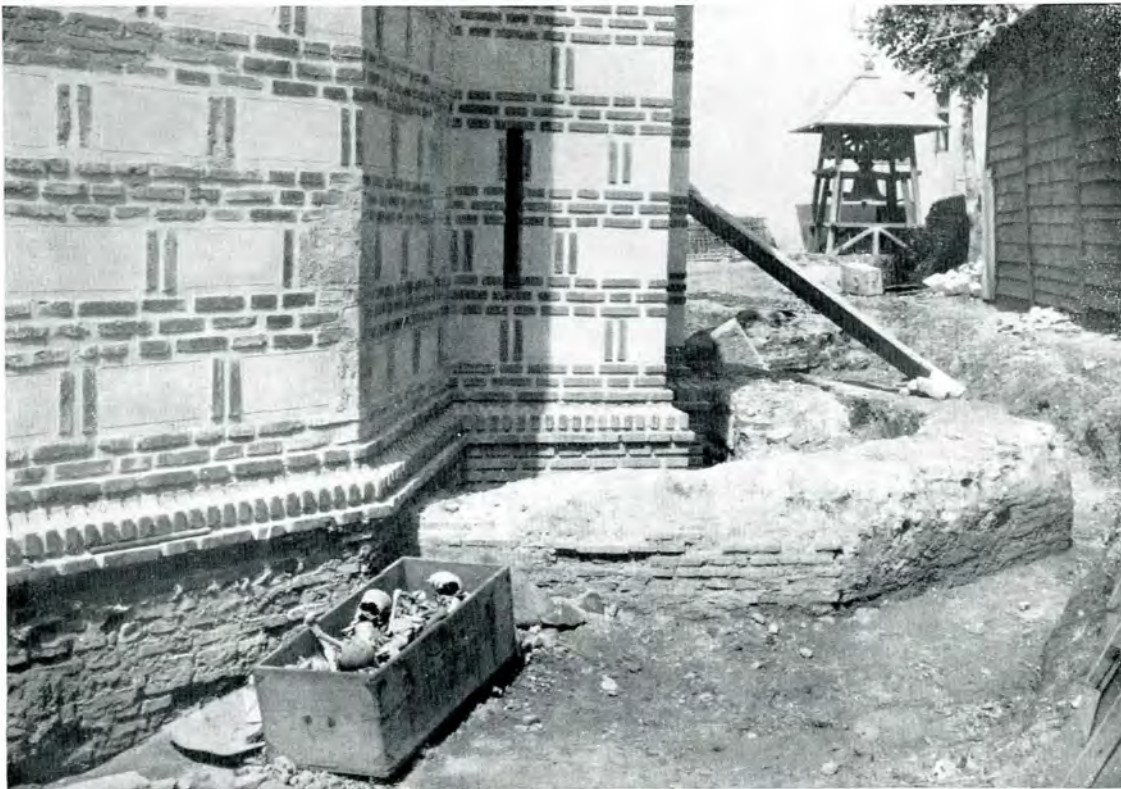
Fig. 86. — Biserica Curtea Veche din București. Detaliul soclului reconstituit.
