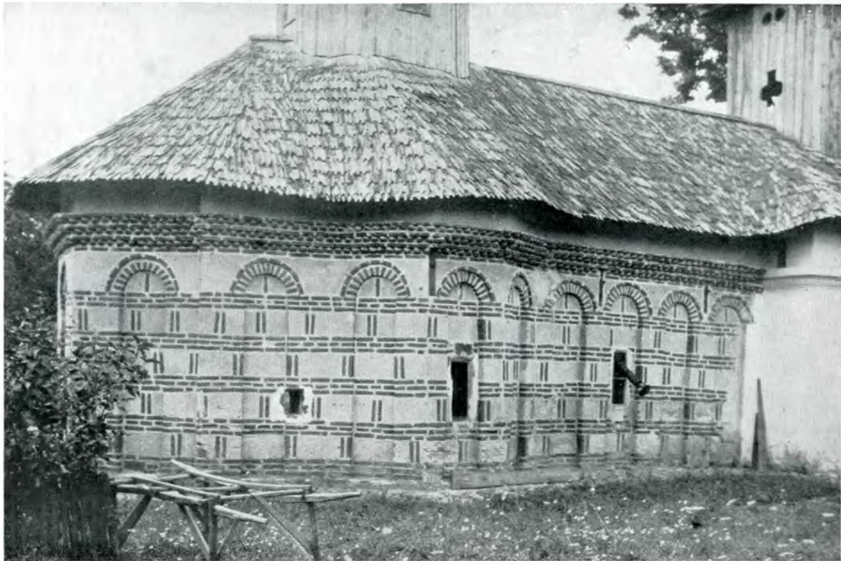
Fig. 63. — Biserica din Olteni (Vâlcea). Vedere laterală.
