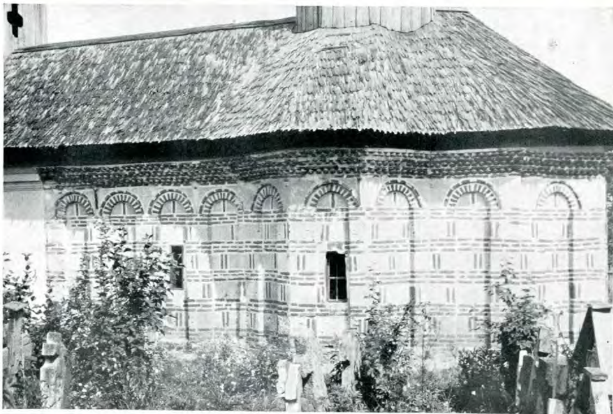
Fig. 64. — Biserica din Olteni (Vâlcea). Vedere laterală.
