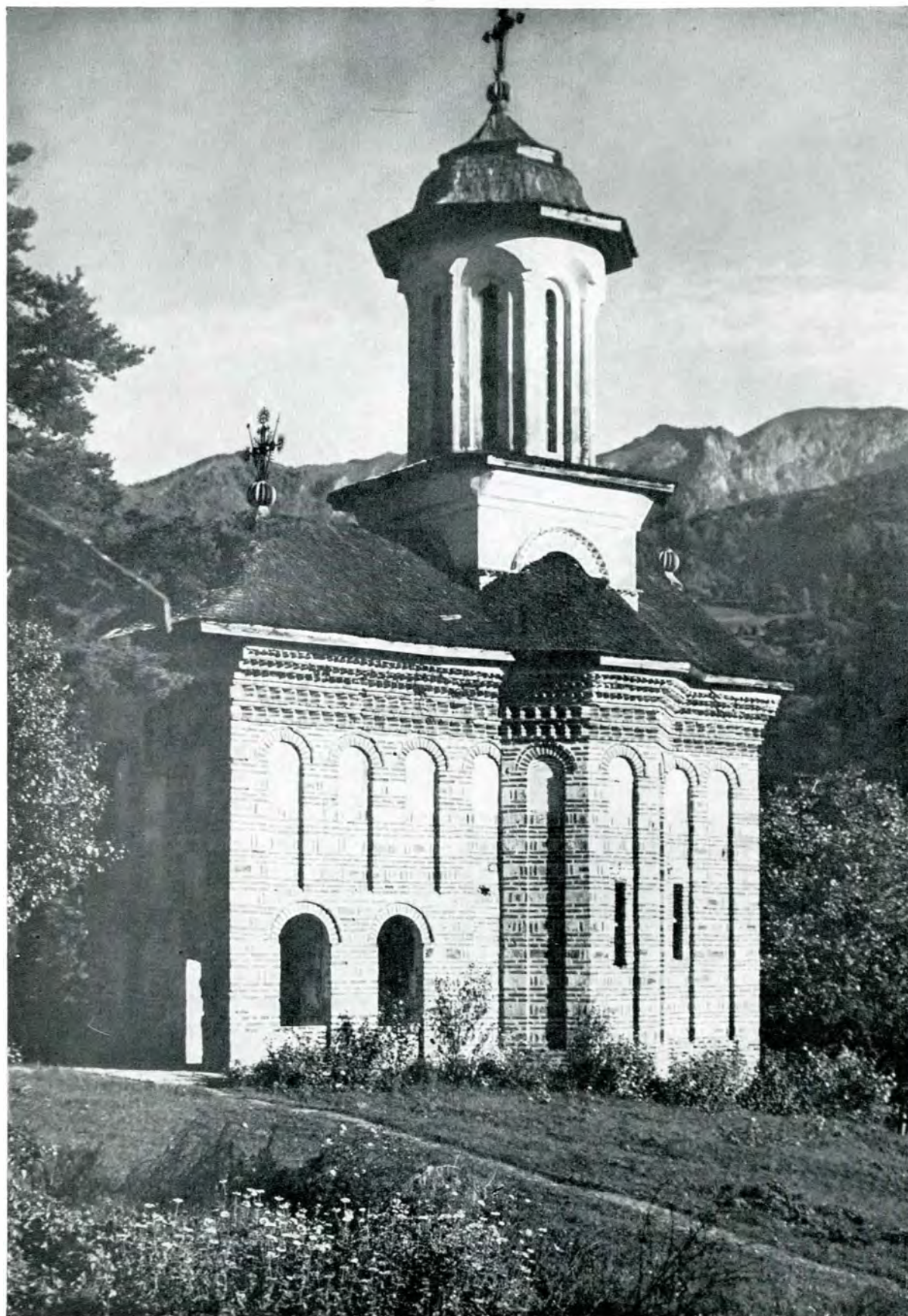
Fig. 72. — Bolnița Mănăstirii Cozia. Vedere generală
