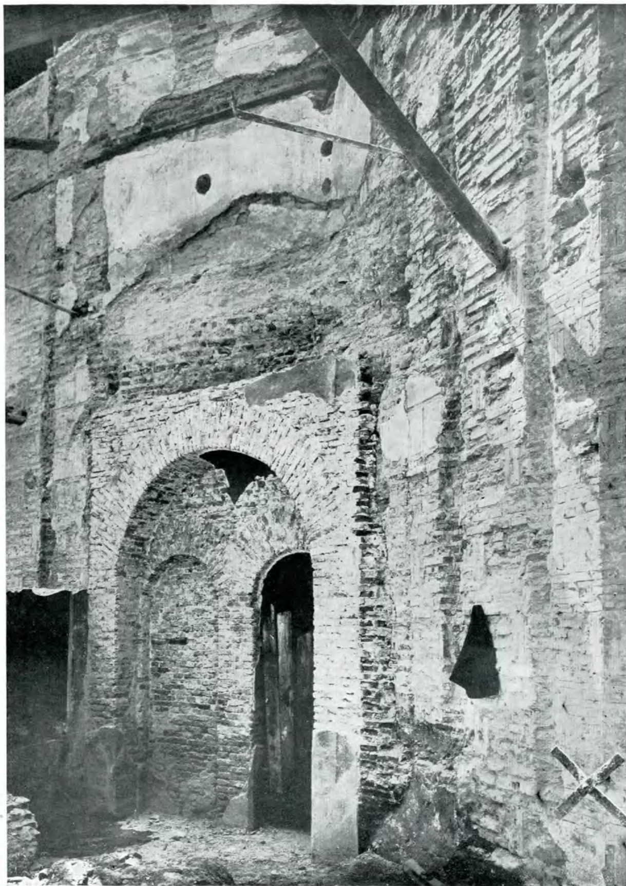
Fig. 84. — Biserica Curtea Veche din București. Detaliu de zidărie în timpul restaurării.
