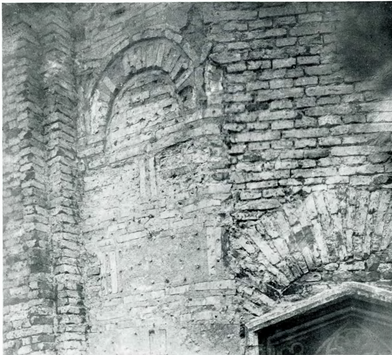
Fig. 83. — Biserica Curtea Veche din București. Detaliu de zidărie înainte de restaurare.
