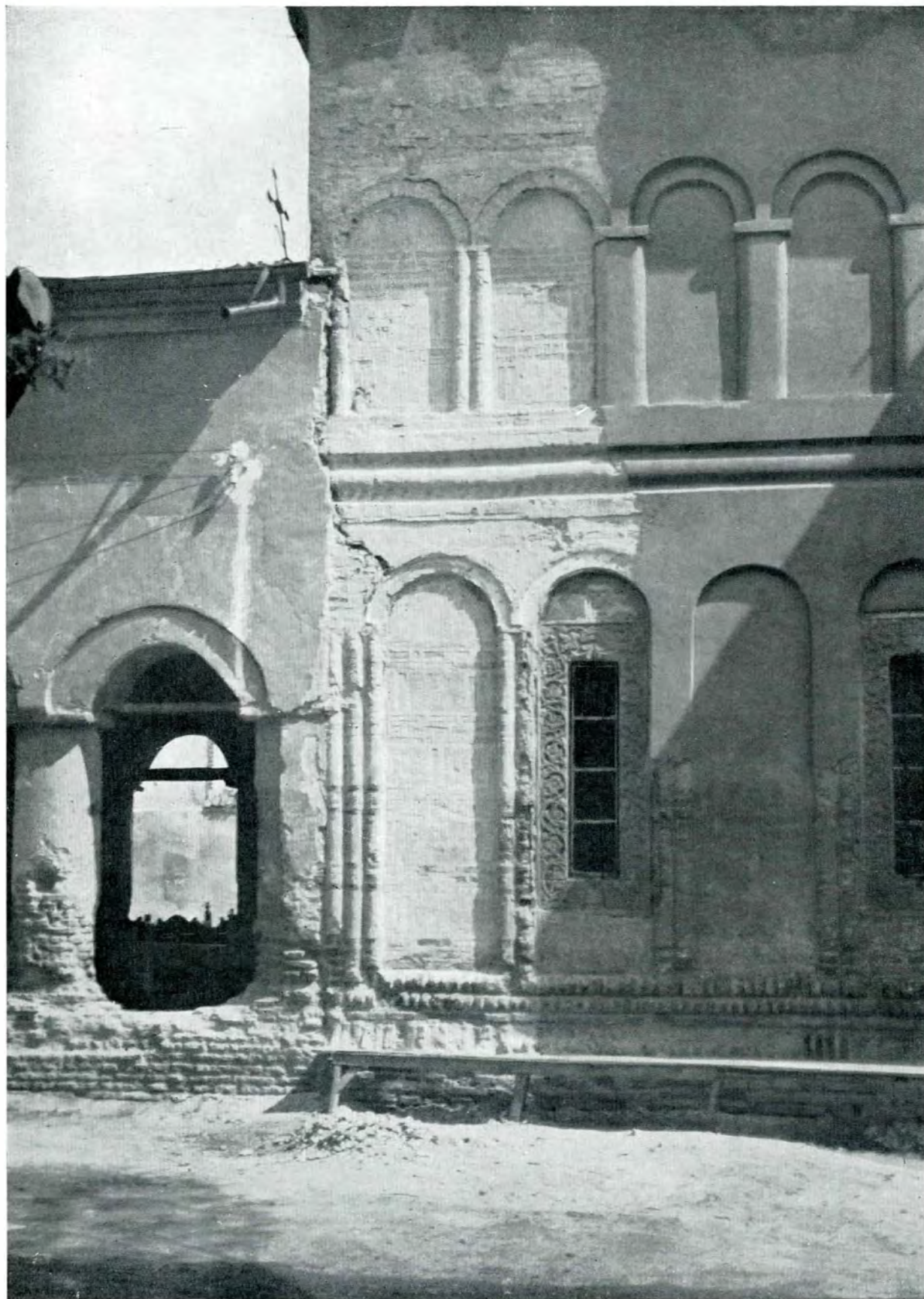
Fig. 107. — Biserica Mănăstirii Mărcuța. Detaliu de fațadă.
