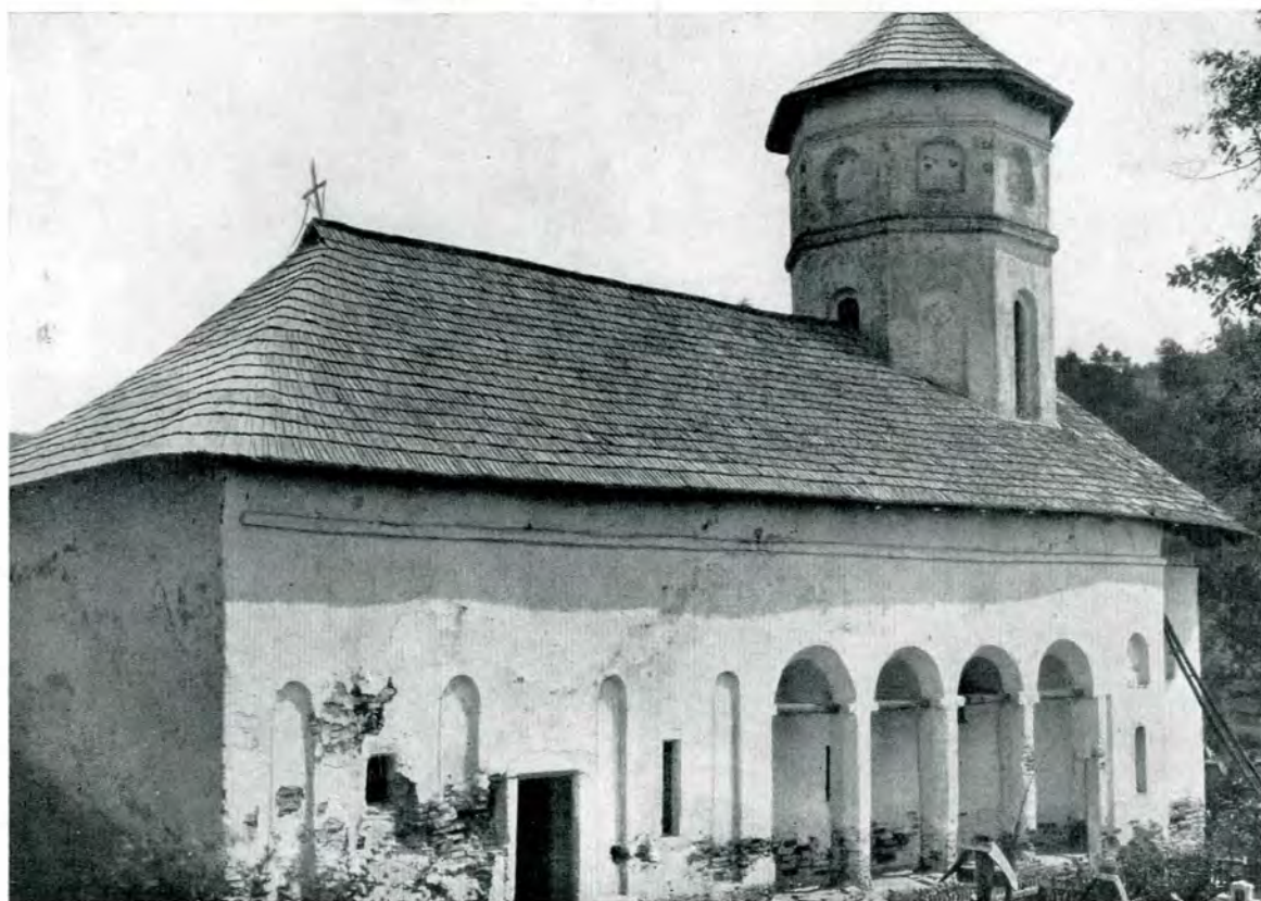
Fig. 55. — Biserica din Stănești (Vâlcea) Vedere laterală
