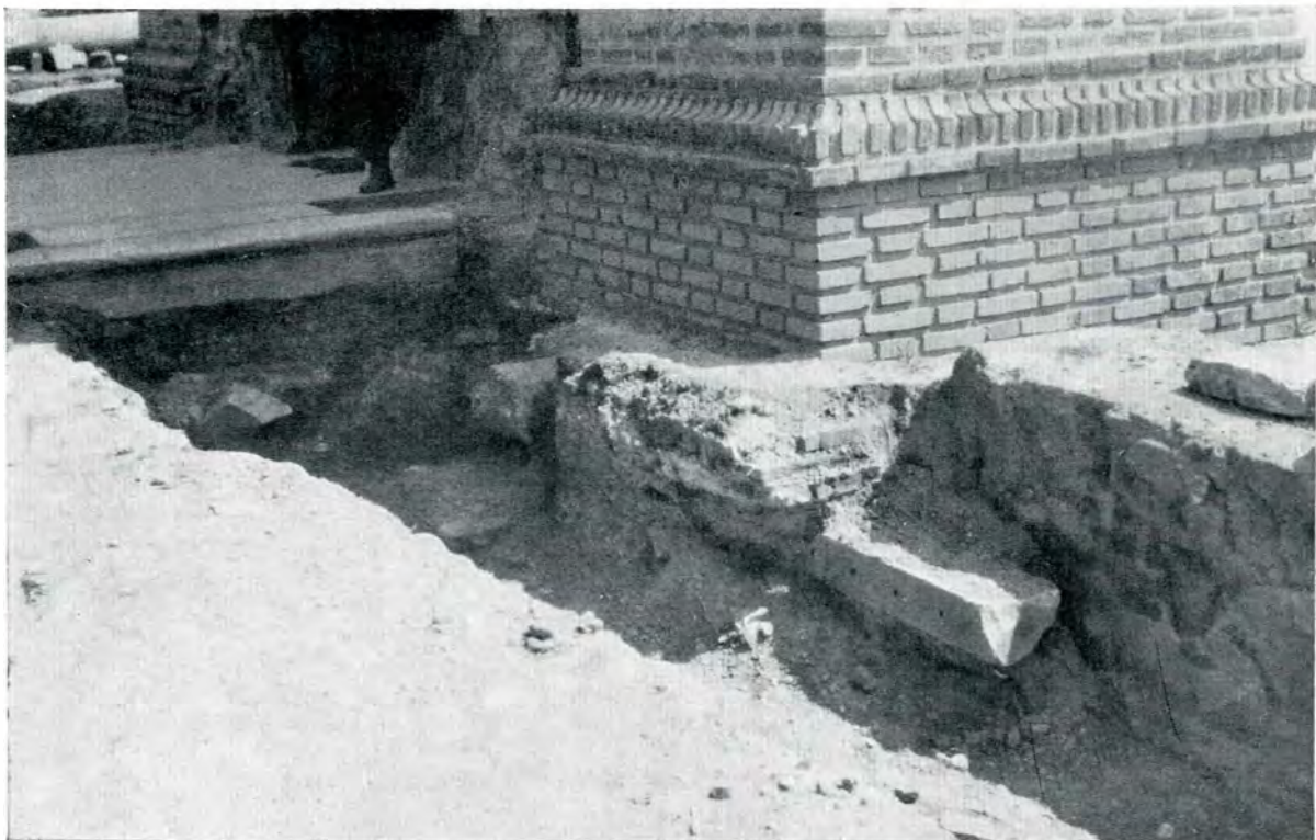
Fig. 87 și 88. — Biserica Curtea Veche din București. Detaliu de zidărie reconstituită.
