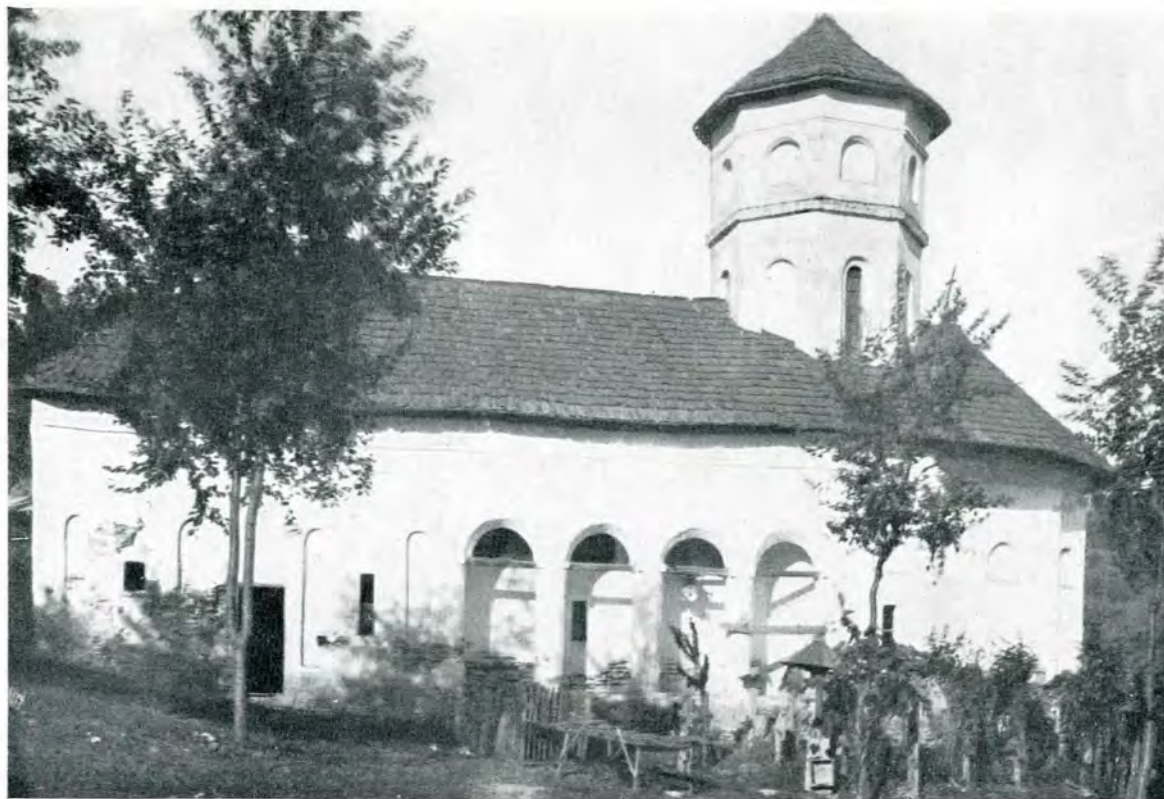
Fig. 54. — Biserica din Stănești (Vâlcea). Vedere laterală.
