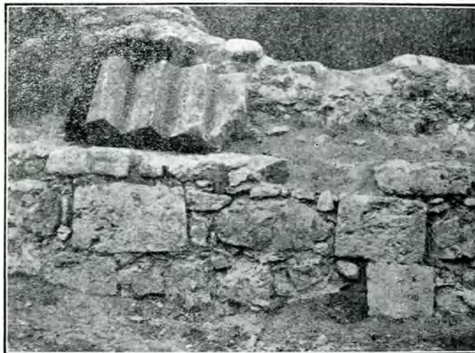
Fig. 7. — Detaliu din paramentul absidei Sud.
