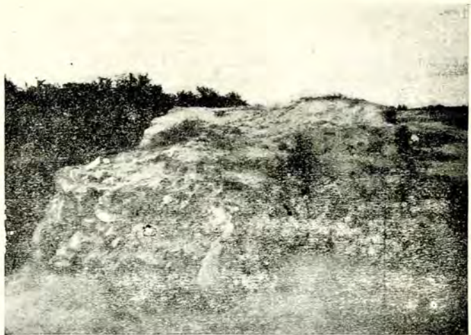
Fig. 4. — Parte din ziduri.
