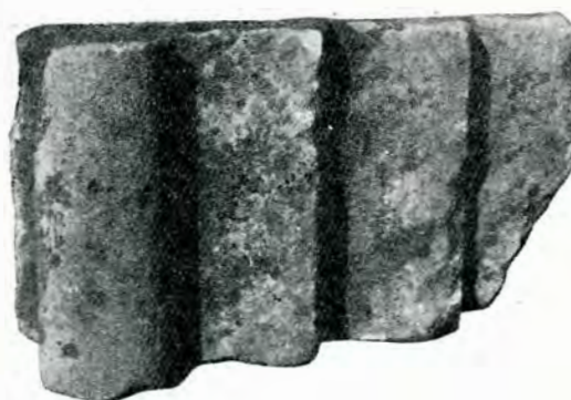
Fig. 14. — Piatră mularată din paramentul exterior al naosului.
