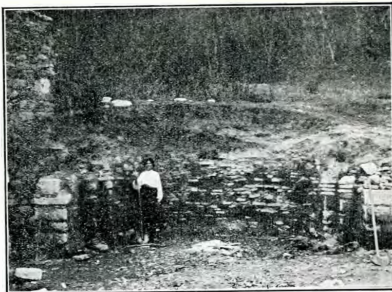
Fig. 12. — Interiorul absidei de Nord a naosului.
