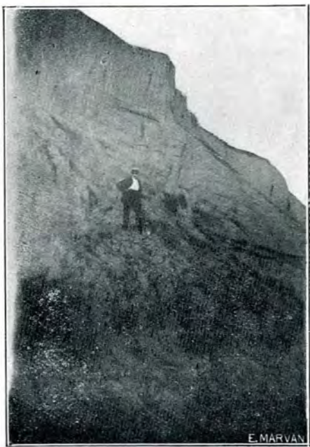
Fig. 15. Stațiunea dela Cornii de Sus, cu vederea laterali de V, surpată de apa Siretiului.
