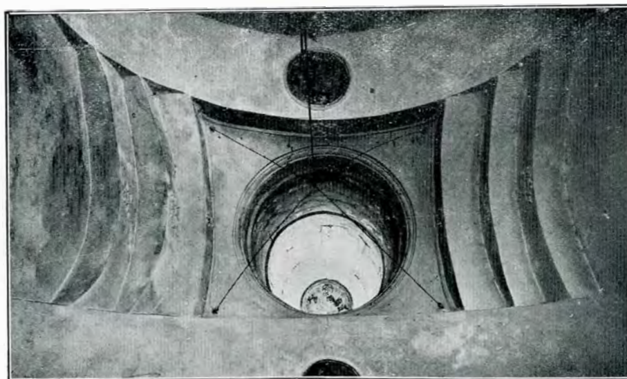
Biserica Armenească din Focșani. Detaliu interior asupra arcurilor bolților.
