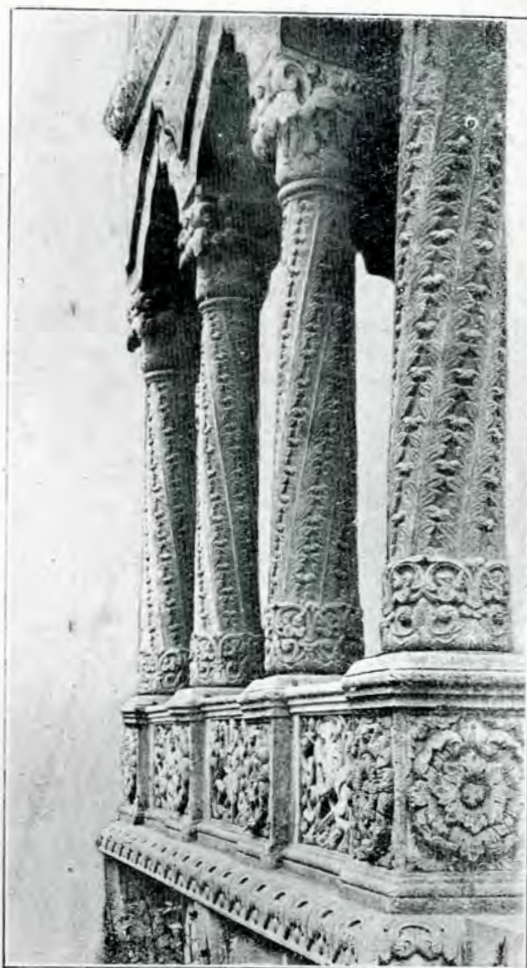
Fig. 17. Coloanele din față ale pridvorului, privite din spre Sud-vest
