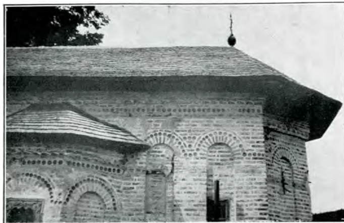
Fig. 90.— Detalii de fațadă.
