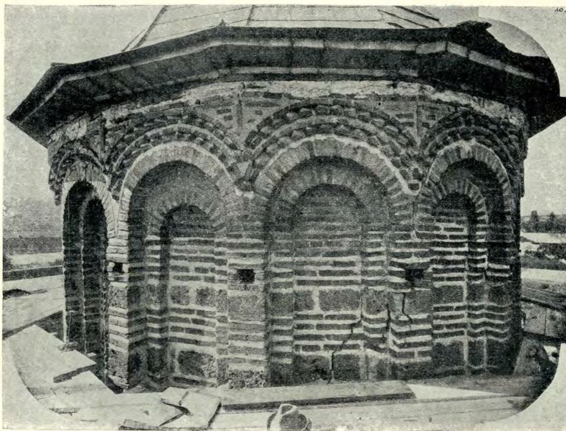
Fig. 99. Degradări în tamburul turlei, spre sud-vest.
