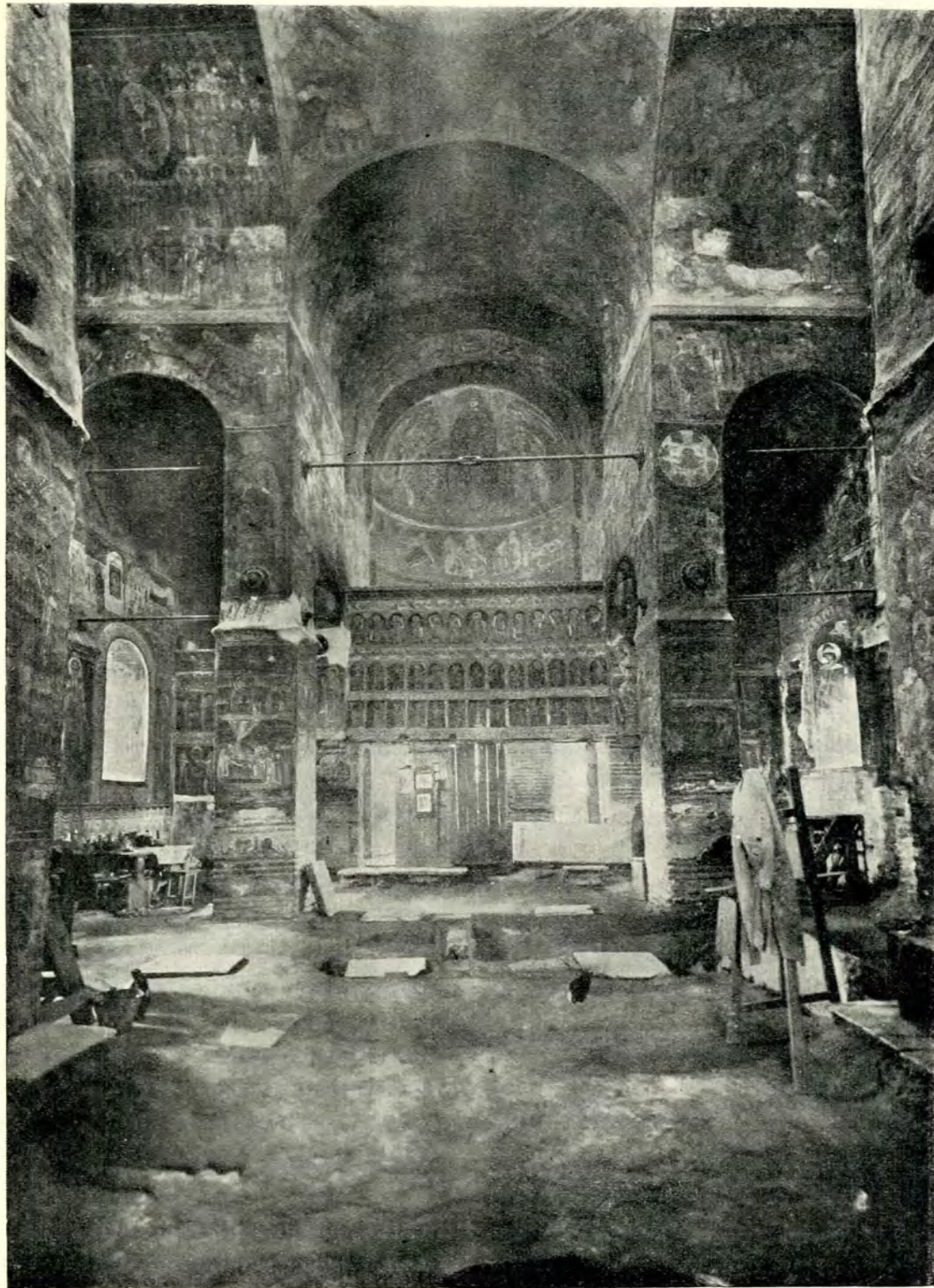
Fig 173. Biserica Domnească, vedere interioară spre altar.
