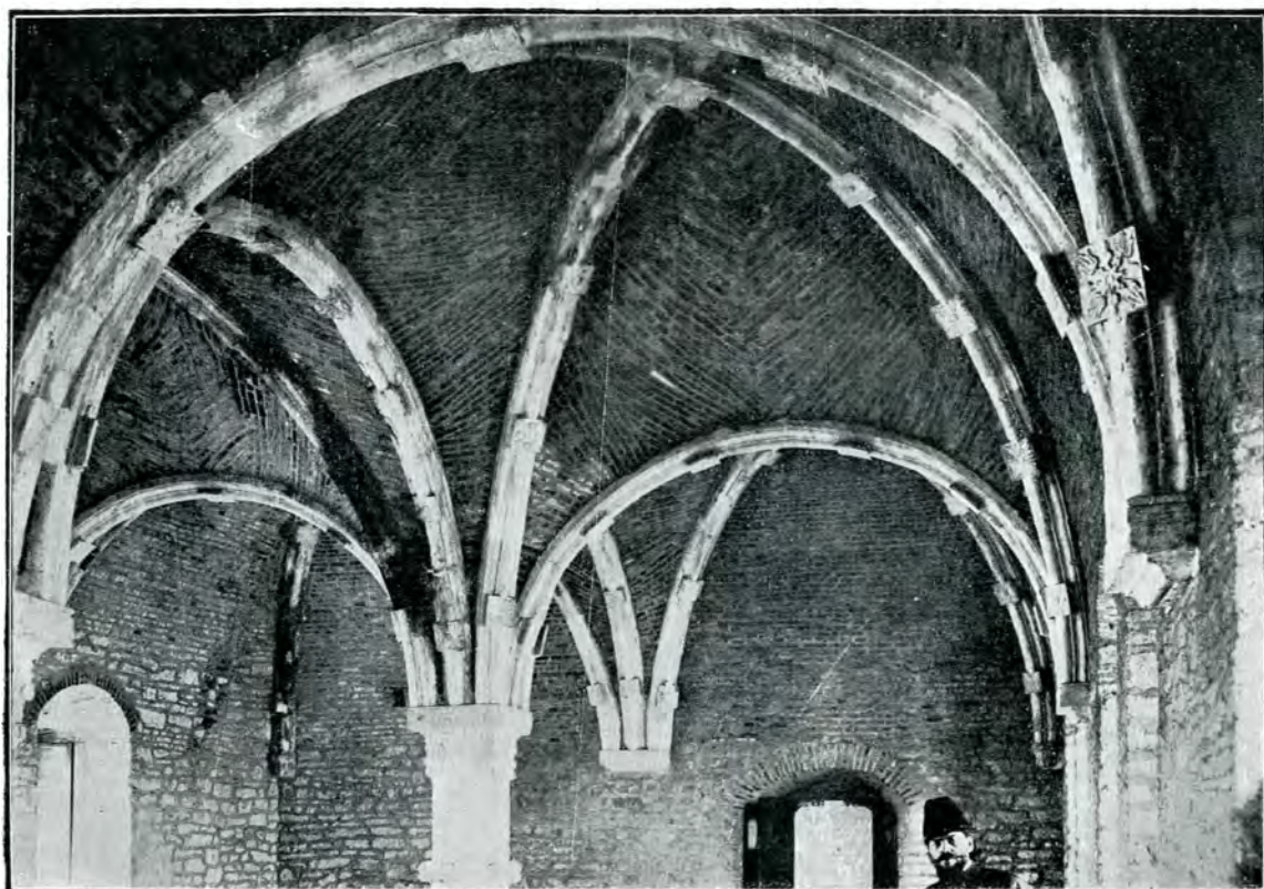
36. Sala gotică (restaurată).
