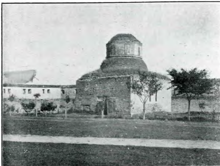
Fig. 24. Cetățuia. Clădirea băii.
