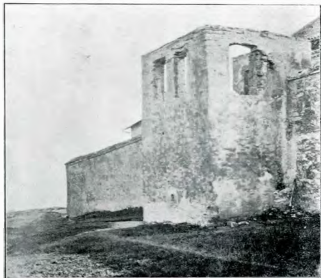
Fig. 23. Cetățuia. Turnul curtinei de nord. Exterior.
