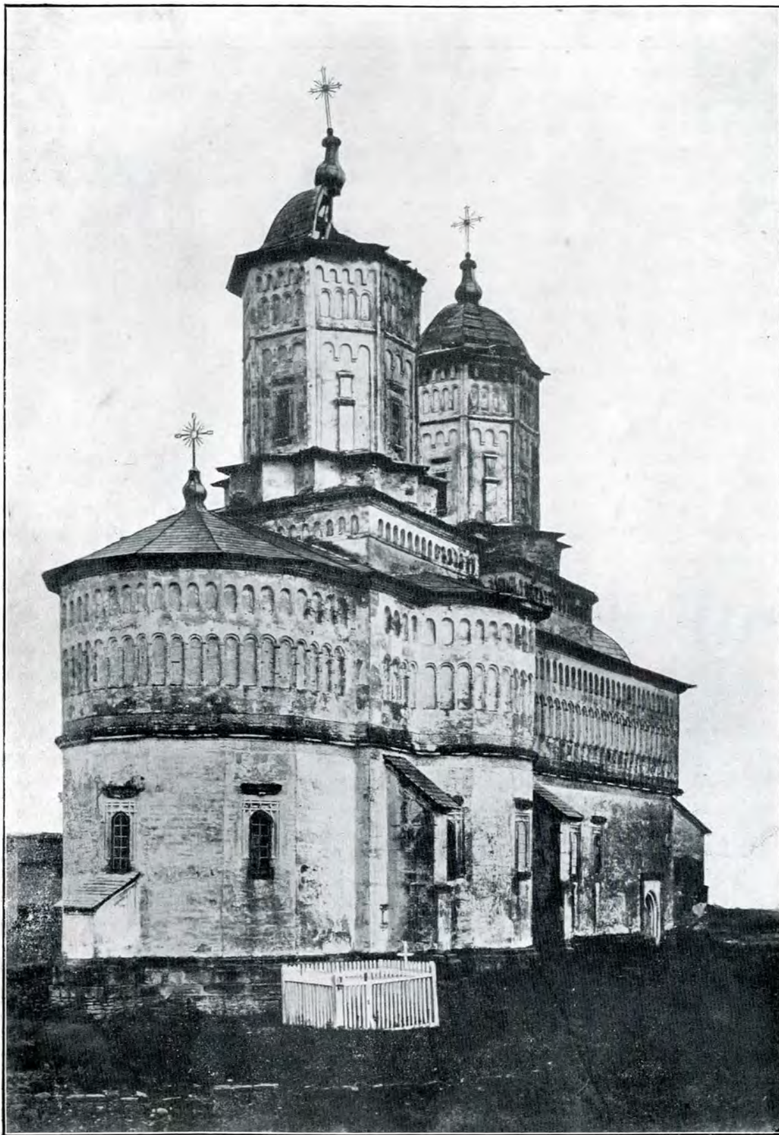
Fig. 16. Cetățuia : biserica mănăstirii. Vedere dinspre nord-est, înainte de restaurarea arhitectului Băicoianu
