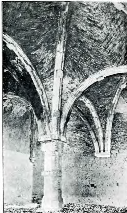
Fig. 50. Vedere de interior. (Sala gotică).
