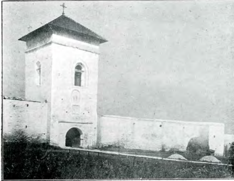
Fig. 20. Cetățuia. Turnul-clopotniță de intrare cu curțina și turnul de flancare. Exterior.
