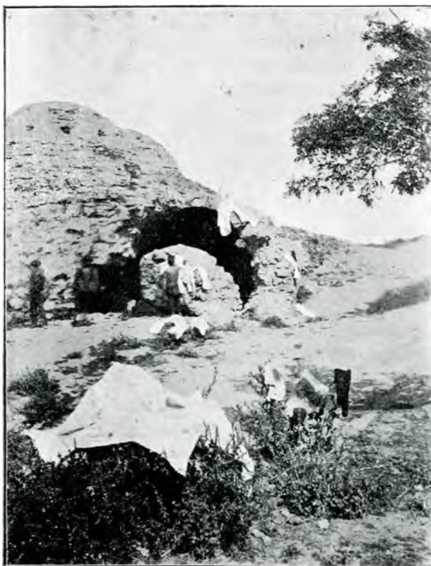
Fig. 25. Rașova. Vederea băii turcești cu apartamentul mașinelor.
