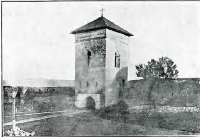
Fig. 22. Cetățuia. Turnul-clopotniță cu curtinile. Interior.
