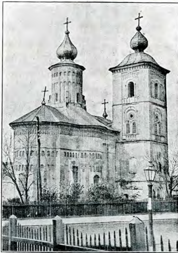
1. Bis. Sf. Gheorghe-Botoșani. Altarul și fațada dela nord cu clopotnița, înainte de restaurare -
