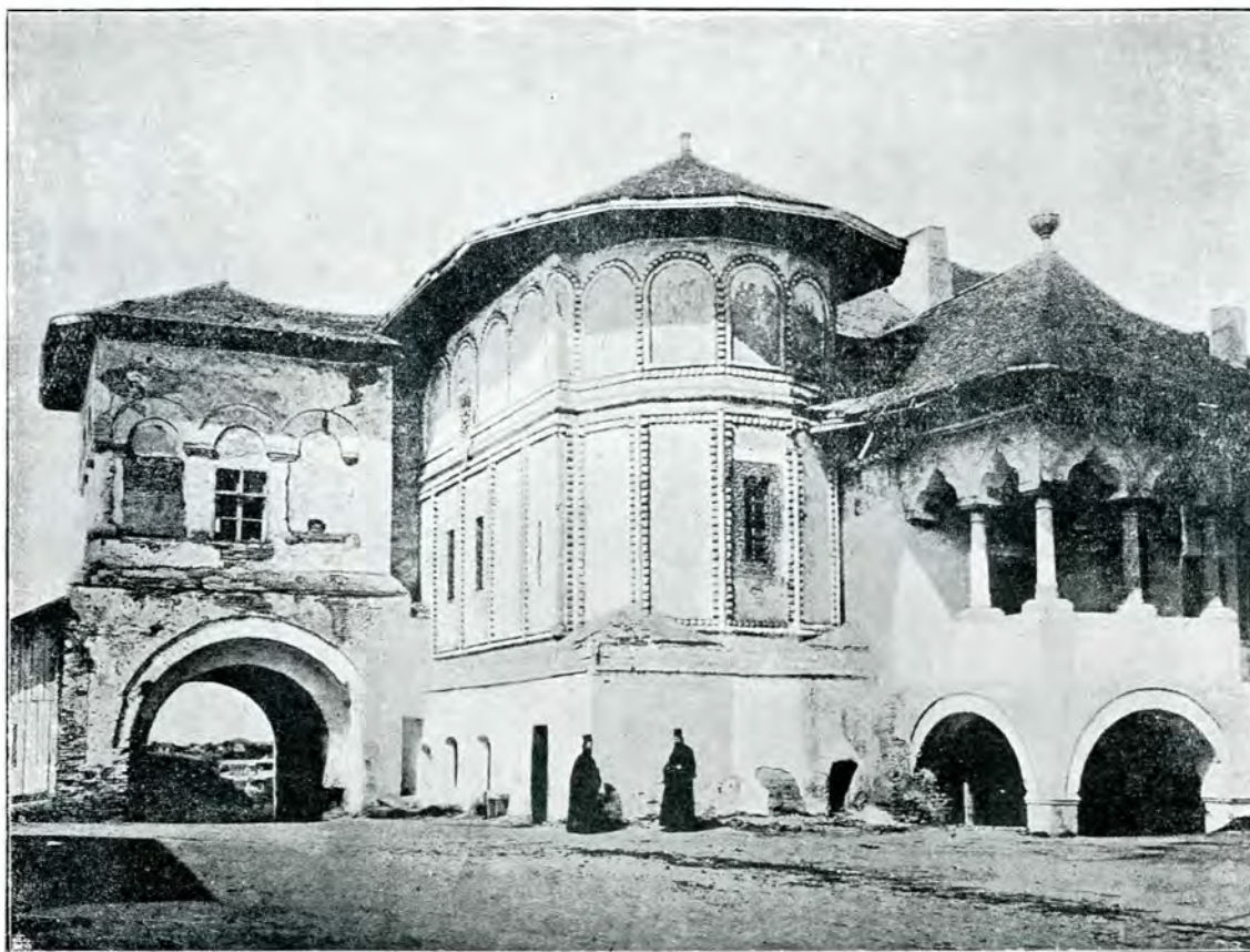
15. Vedere a paraclisului, cu foișorul și vechea clopotniță, după o fotografie dinainte de 1850.
