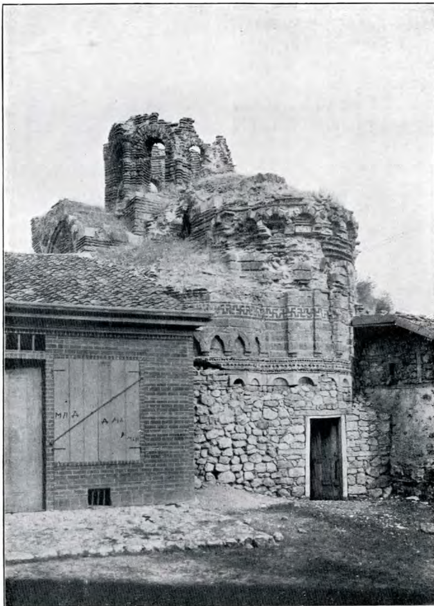
25. Biserica Pantocratorului. Vedere spre absidă.
