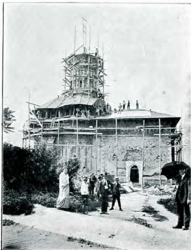
5. Bis. Sf. Gheorghe-Botoșani. — Fațada dela nord, în curs de restaurare —
