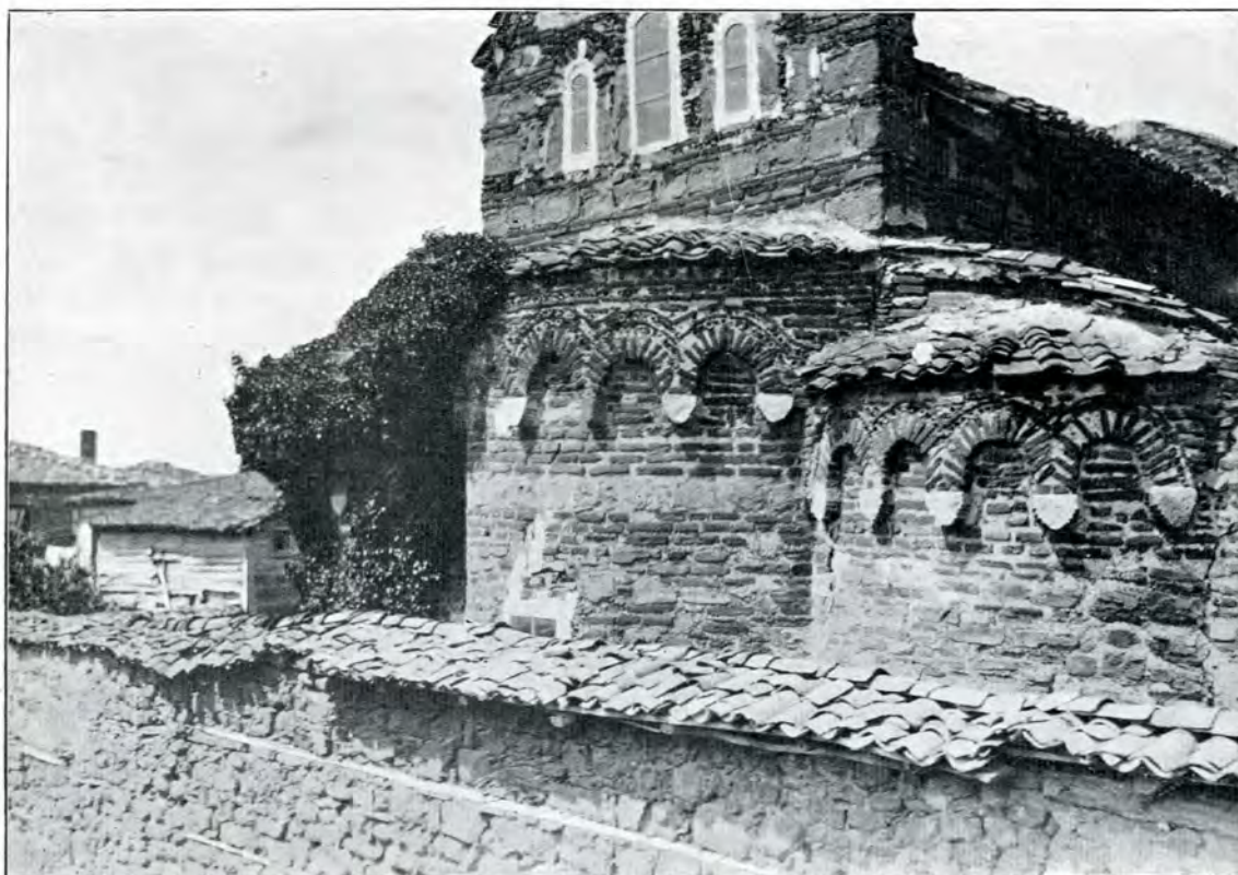
11. Mitropolia nouă. Vedere spre absidă.
