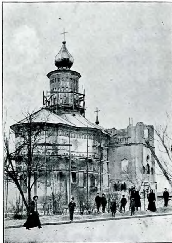
3. Bis. Sf. Gheorghe-Botoșani. — Vederea dela No. 1, în timpul lucrărilor —
