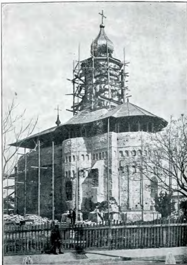
4. Bis. Sf. Gheorghe-Botoșani. — Vederea dela No. 2, în timpul lucrărilor —
