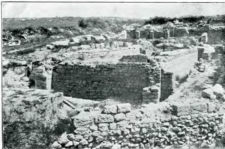
Fig. 30. Vedere generală a ruinelor basiliciei-cisterne (fot. ing. St. Petrescu).
