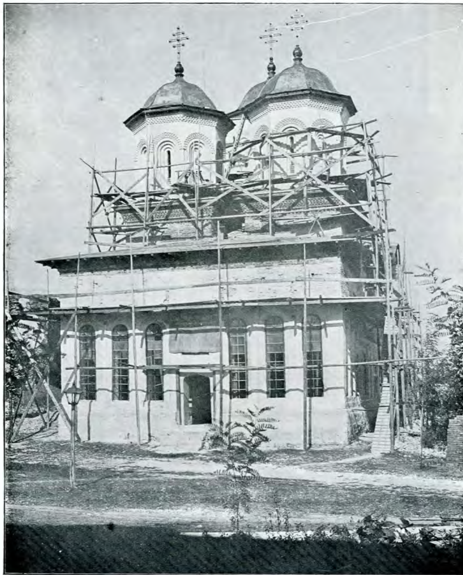
Biserica Domnească din Târgoviște. (Fațada principală, în timpul restaurării).
