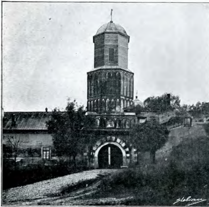
Turnul-clopotniță dela Mănăstirea Brâncovenii. — Epoca Matei Vodă. —
