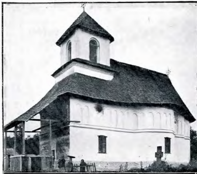
Biserica din Rămeștii-Vâlcei. Vedere asupra laturei de sud.
