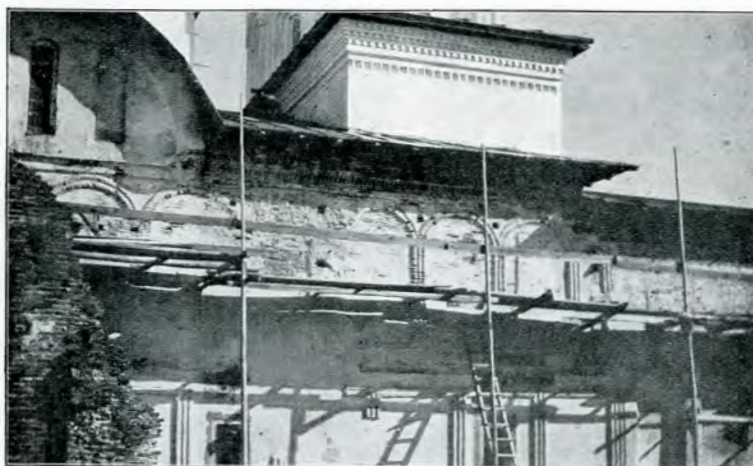
Biserica Domnească din Cărgoviște. (Detaliu dela cornișe, în timpul restaurării).
