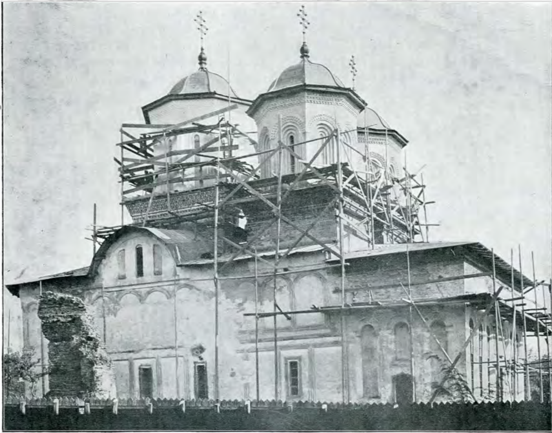
Biserica Domnească din Târgoviște. (Fața dela Nord, în timpul restaurării).
