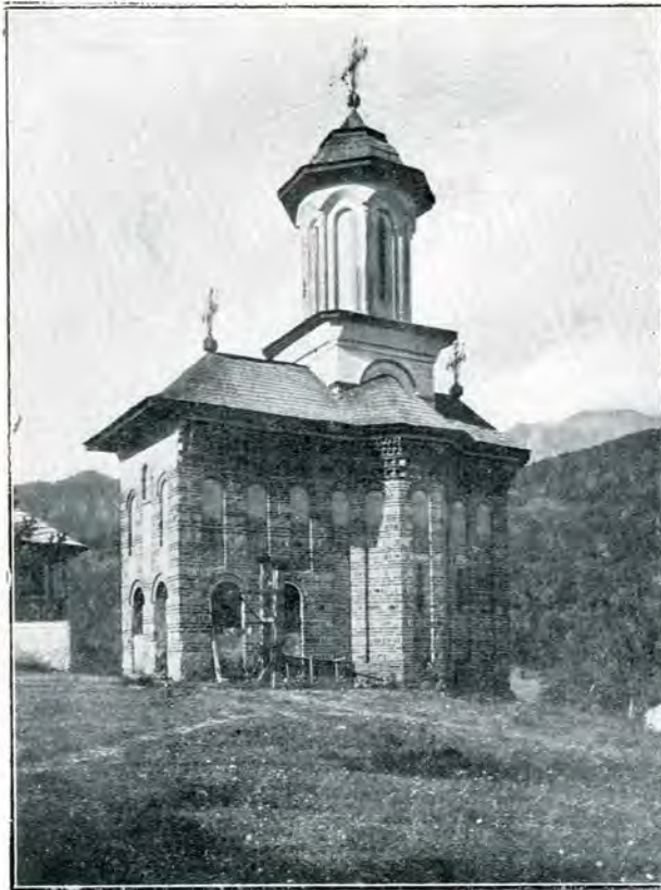
26. Bolnița mănăstirii Cozia. (Înaintea lucrărilor de conservare).
