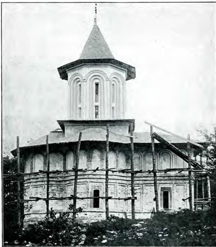
29. Schitul Sf. Ștefan — În timpul restaurării —
