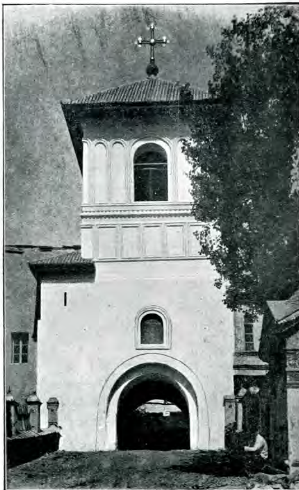
27. Clopotnița dela Harezi — După restaurare —
