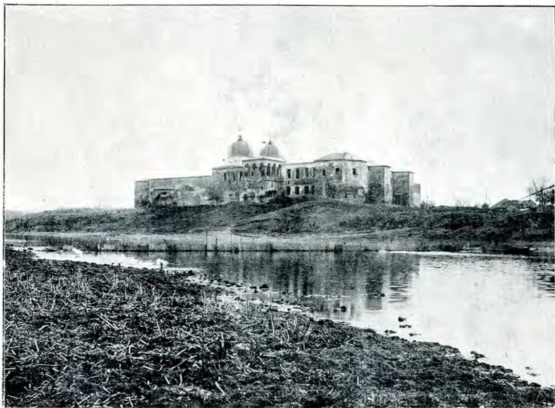
1. Mănăstirea Comana: Vedere generală.
