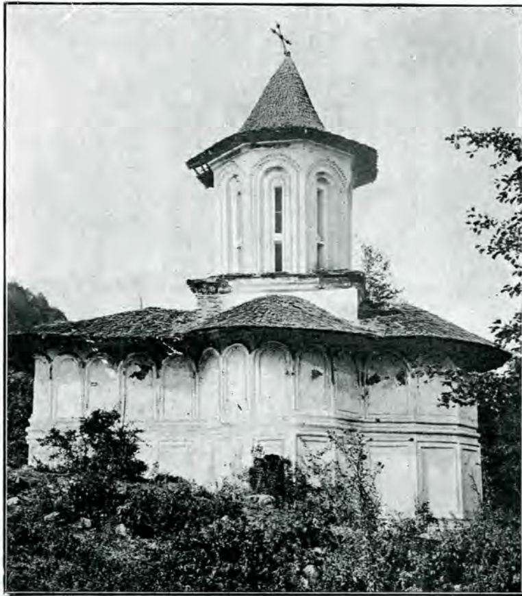
28. Schital Sf. Ștefan — Înainte de restaurare —
