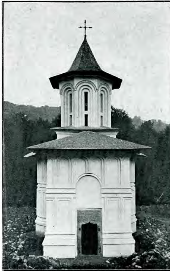
31. Schitul Sf. Ștefan — După restaurare —
