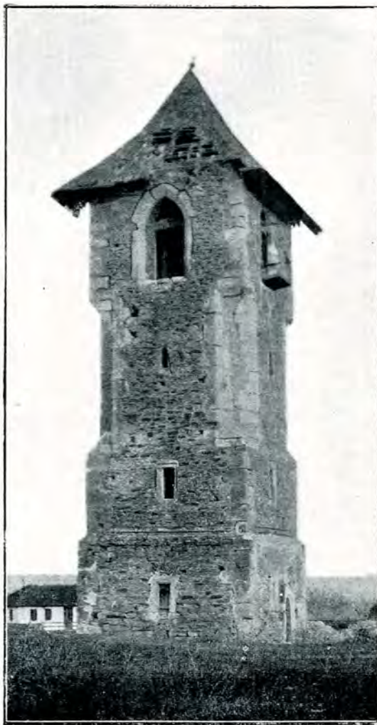
21. Clopotnița dela Păpăuți. (In curs de restaurare).
