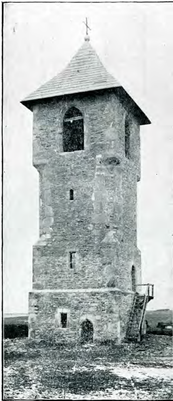
22. Clopotnița dela Păpăuți — După restaurare 1) —
