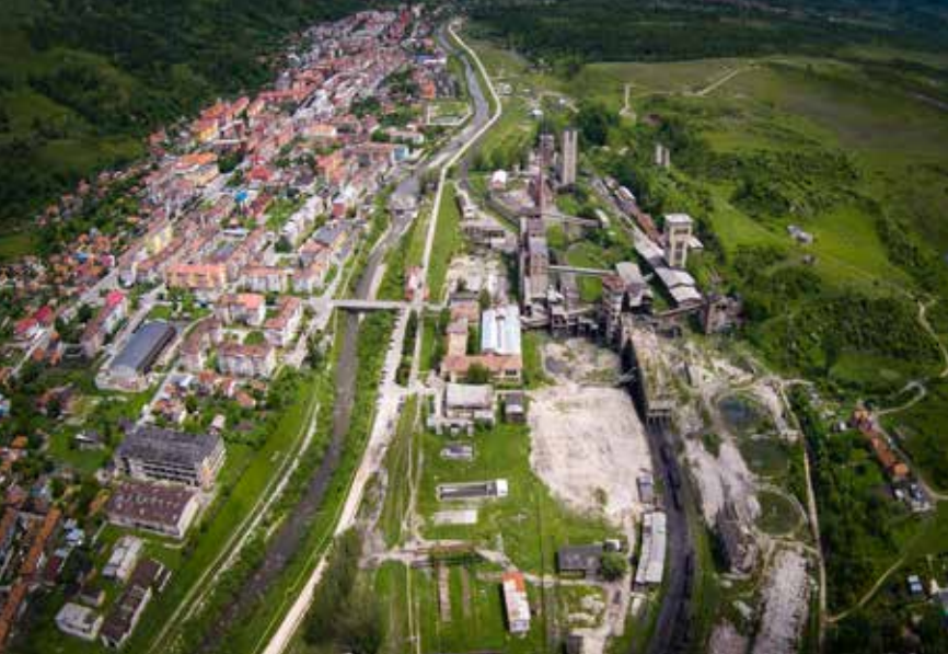
Fig. 1 Perspectivă aeriană cu orașul Petrița și Exploatarea Minieră Petrița, în timpul demolărilor (foto Andrei Dăscălescu)
