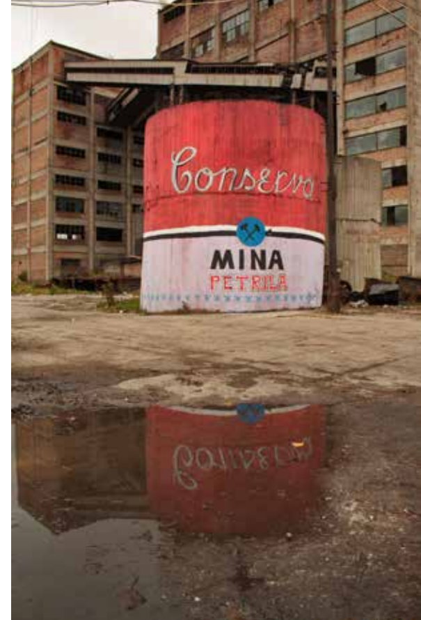
Fig. 3 „Conservă Mina Petrița”, lucrare demolată de Societatea de Închideri Mine (foto Cristina Sucală)
