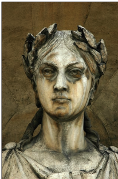
Fig. 10 - Cruste negre formate atât pe statui, cât și pe moloanele din zidărie, adesea combinate cu leucocruste, mai recente. / Black crusts formed on both the statues and the blocks of masonry, often combined with latest leucocrusts.
