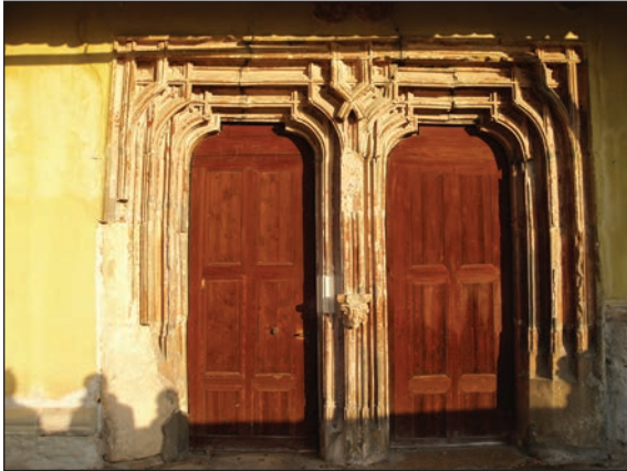
Fig. 7 - Biertan. Portalul de vest al bisericii evanghelice fortificate (c. 1500). Deteriorări și intervenții nocive / Biertan. West portal (about 1500) - deteriorations and harmful interventions
