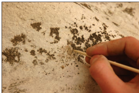
Fig. 16 - Îndepărtarea manuală a biocrusteii, fațada Lipscani / Manual removal of biocrusts., the Lipscani facade.
