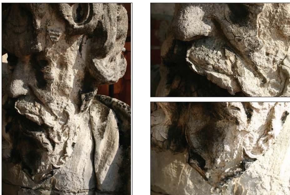
Fig. 14 - Degradare complexă: dizolvare, dezagregare, termofisurare, crustificare și biodegradare. / Complex degradation: dissolution, disintegration, termofisurations, crusting and biodegradation.
