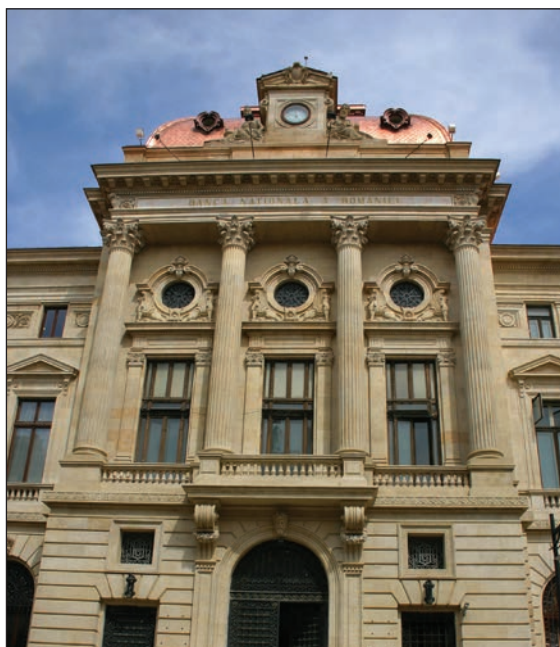
Fig. 33 - Zona centrală a fațadei Lipscani, (a) înainte, (b) după intervenție / Middle part of Lipscani facade (detail). National Bank of Romania, (a) before, (b) after intervention.
