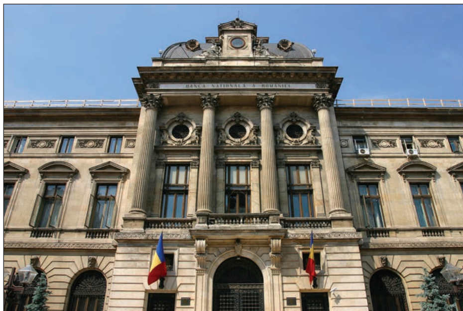
Fig. 1 - Banca Națională a României, fațada sudică / National Bank of Romania, southern facade.
