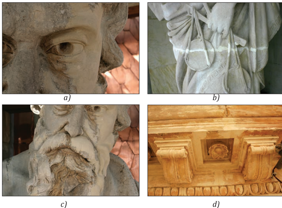
Fig. 22 - Exemple de chituiiri, plombări și reconstrucții volumetrică cu mortar special de restaurare; zonele deschise din (a), (b), (c) și (d), reprezintă completările efectuate, înainte de retușul cromatic, fațada Lipsca / Examples of fillings, locking and volumetric reconstructions using special restoration mortar; the light areas in (a), (b), (c) and (d), are completions made before the chromatic integration, the Lipsca facade.
