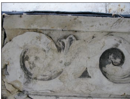
Fig. 4 - Cruste de degradare în nuanțe maronii / cenușii, funcție de poziția molonului în edificiu și de detaliile sculpturale. / Degradation crusts in brown / gray shades, depending on the position of the block in the building and the sculptural details.
