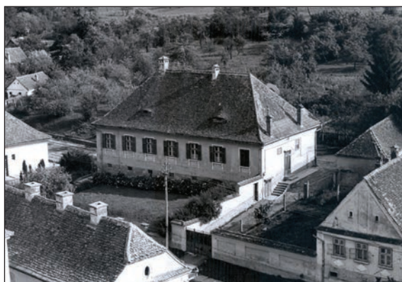
Fig. 9 Casa parohială evanghelică / Maison paroissiale évangélique
