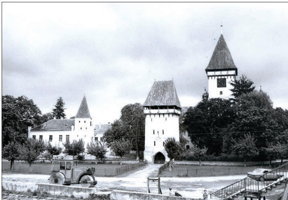
Fig. 5 Ansamblul bisericii evanghelice (dinspre N) / Vue d'ensemble de l'église évangélique (du côté de nord)
