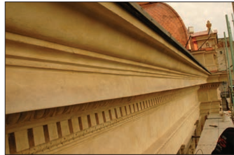
Fig. 29 - Aspect al cornișei (a) înainte, (b) după intervenție, fațada Lipscani / Aspect of cornice (a) before, (b) after intervention, the Lipscani facade.
