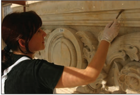
Fig. 23 - Integrarea cromatica a suprafetelor la nivelul patinei, fațada Lipscani / Chromatic integration of the surfaces to the patina level, the Lipscani facade.
