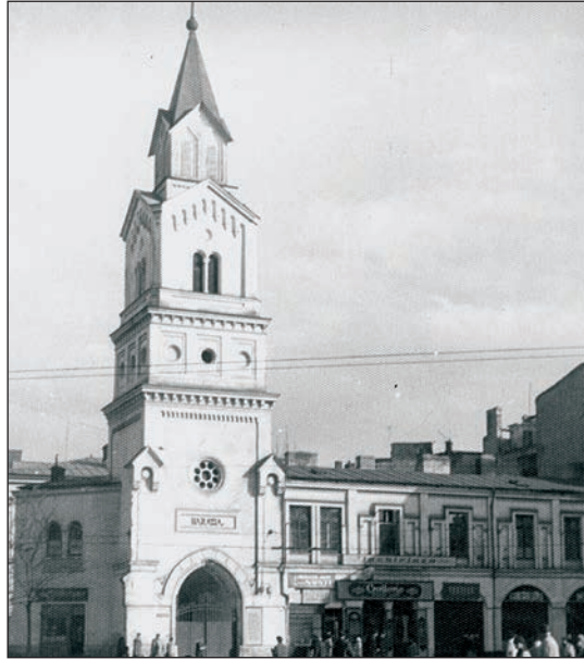
Fig. 10 – Turnul Bărăției și corpul monastic cu prăvălii – 1964 (INP – Fototecă) / Bărăția Tower and monastic building with shops – 1964 (INP – Photographic archive)
