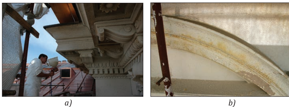
Fig. 18 - Extragerea sărurilor solubile prin comprese: aplicarea compresei prin pulverizare (a); detaliu al unei suprafețe cu compresa uscată, salinizată, înainte de îndepărtare (b). Suprafața de calcar după îndepărtarea compresei, fațada Lipscani / Extraction of soluble salts by compresses: compress application by spraying (a) detail of dry surface of the salinated compress before removal. (b). The limestone surface after compress removal, Lipscani facade.
