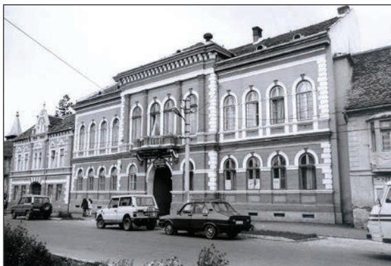
Fig. 11 "Noua" primărie / Mairie bâtie en 1885, appelée la „nouvelle” mairie
