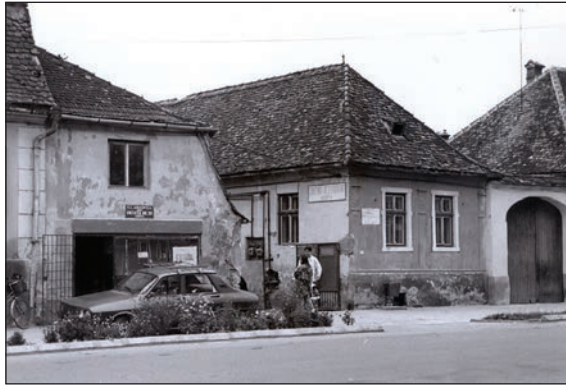
Fig. 13 Locuința îngrijitorului fostelor grajduri comunale / Logement de la personne en charge des anciennes étables communales
