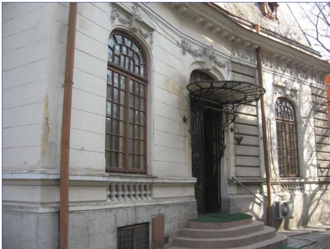
Fig. 10. Fațada dinspre curte – intrarea principală
