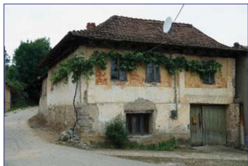
Fig. 4. Casă de la sfârșitul sec. al XIX-lea, construită din piatră și cărămidă arsă combinată cu chirpici
