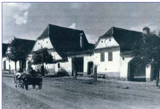
Fig. 25. Șaroș pe Târnave/Scharosch an der Kokel. Casa parohială evanghelică. Foto: Aurelian STROE, 1994. Reproducere din sursa de la Fig. 11.
