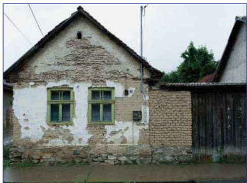
Fig. 3. Casă de la sfârșitul sec. al XIX-lea, dezvoltată în adâncime, pe lot; construită din chirpici (cărămidă nearsă), cu frontonul făcut dintr-o structură ușoară de lemn, stuf și mortar de lut cu nisip
