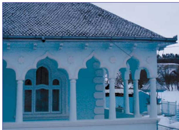
Fig. 20 a, Casă țărănească din com. Cracaoani,, jud. Neamț
