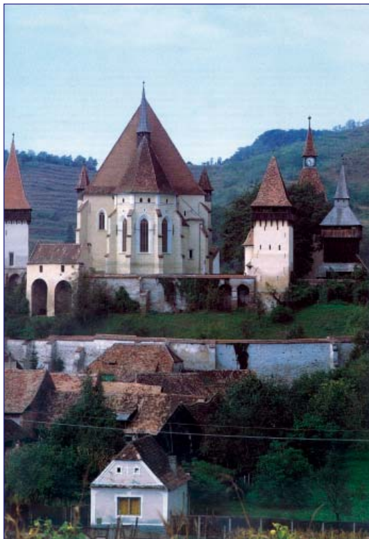
Fig. 15. Biserica fortificată din Biertan/Birthälm, în raport cu o parte a satului. Foto: George DUMITRIU. Reproducere din Denkmäler in Rumänien. Monuments en Roumanie, 1995, p. 6.
