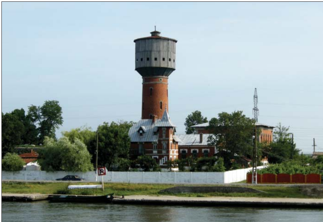
Fig. 13. Uzina de apă, vedere de pe canalul navigabil, foto 2007
