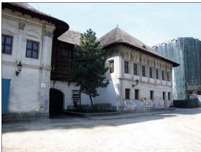
Fig. 16. Hanul lui Manuc . Fațada dinspre str. Franceză
