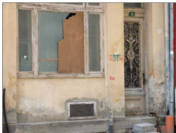
Fig. 14 - Obturarea voluntară a deschiderilor clădirii duce la lipsirea acesteia de ventilația neapărat necesară sănătății sale
