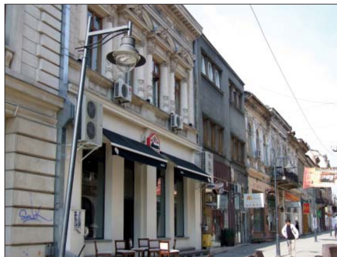
Fig. 3 - Exemplu de “degradări estetice”
