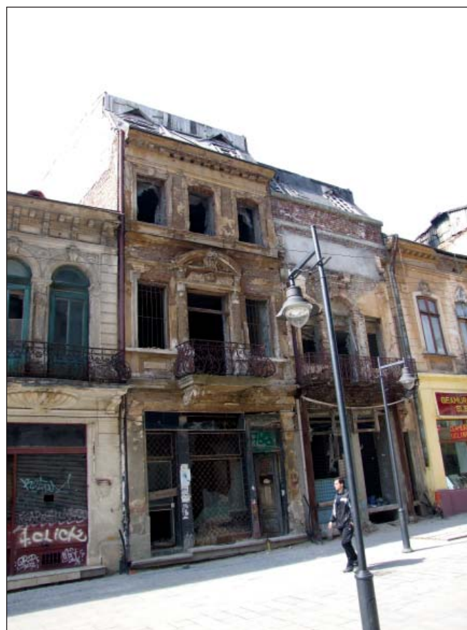
Fig. 4 - Lucrări începute și nefinalizate
