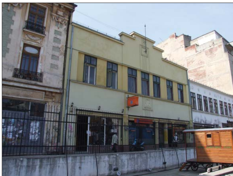
Fig. 56. Casa de pe strada Franceză nr. 56 – Fațadă cu intervenții
