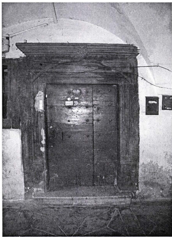
II. 7. Ancadrament de ușă, datat 1550 din casa din str. Mureșenilor 9
