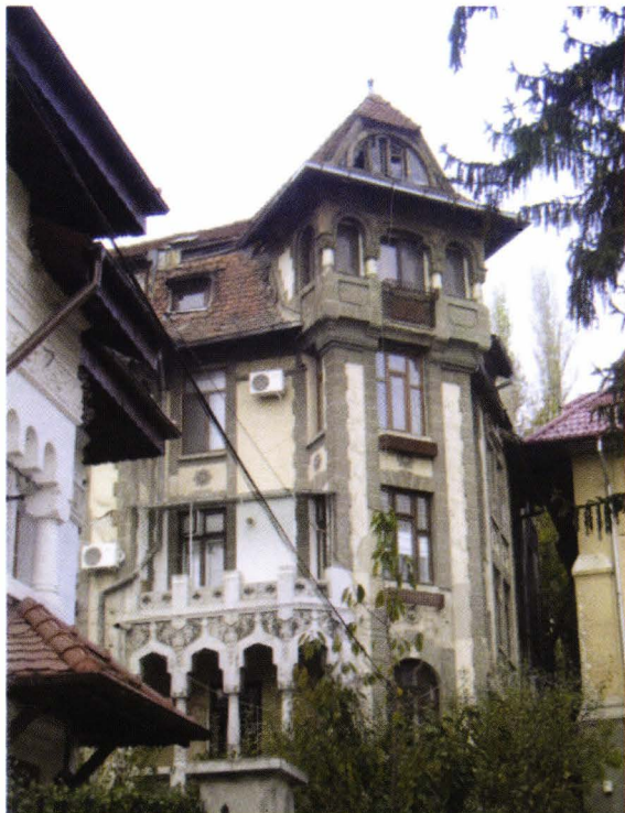
20. Vila „arh. Ada Zăgănescu”, aleea Dealul Mitropoliei nr.19, arh. Ar. Culina
