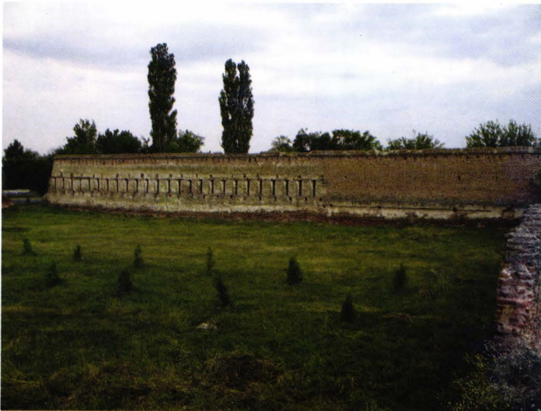
II. 8. - Zidul de incintă de pe latura de nord
