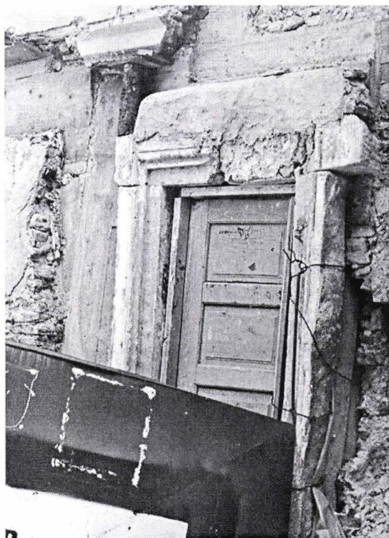
II. 6. Ancadrament de ușă din casa din Piața Sfatului 16
