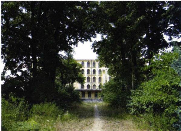
II. 7. „Depozit de tutun“, din Crevedia, ansamblu de clădiri și parc, jud. Giurgiu
