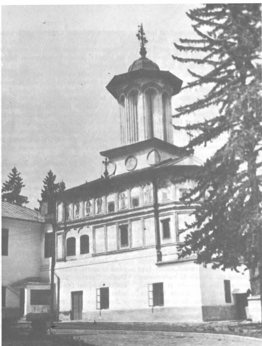
Paraclisul Episcopiei Rîmnicului, vedere din partea de sud-est
