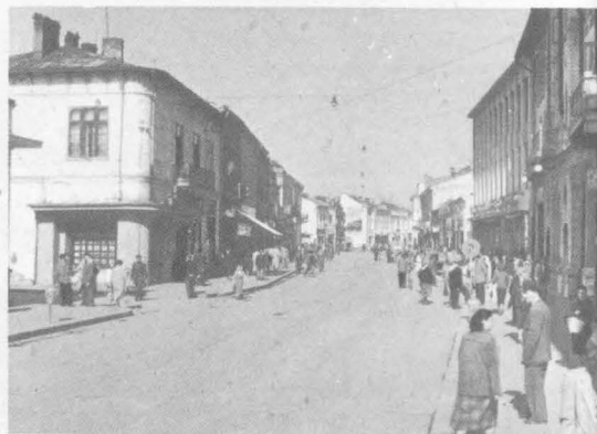
Bacău. Strada comercială («strada Mare») dispărută în urma sistematizării orașului (foto. 1960)
