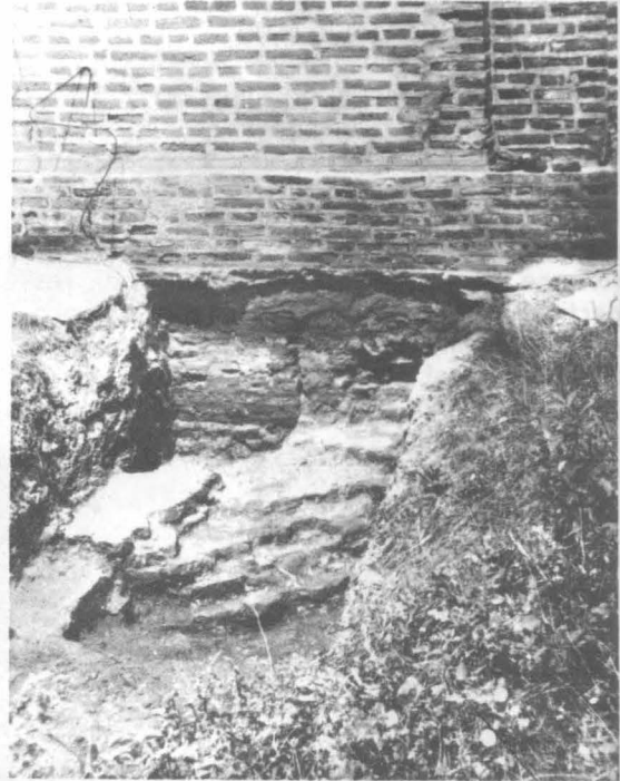
Fig. 10. Fundația abisidiotei de pe latura de sud a pronaosului.
