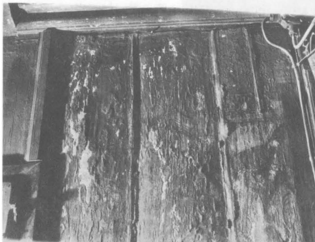
Fig. 5. Naos, peretele de sud: panoul cu «Minunea slăbănogului», înainte de restaurare, cu aspectul repictărilor ce au mascat degradările, depunerea stratului de fum și noi forme de degradări.
