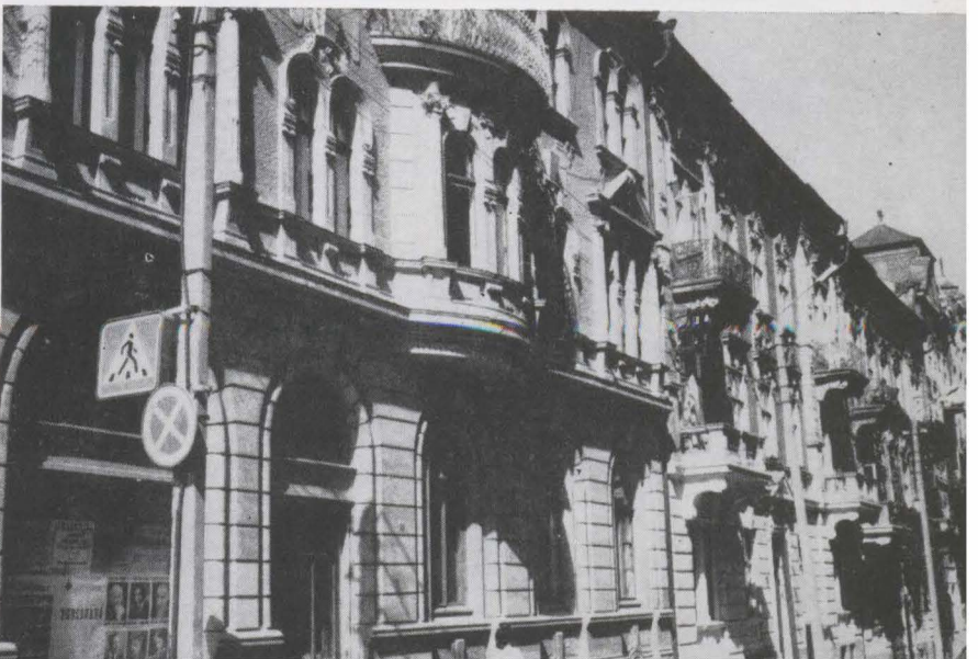
Fig. 3. Cernăuți, str. Kotliarevskovo
