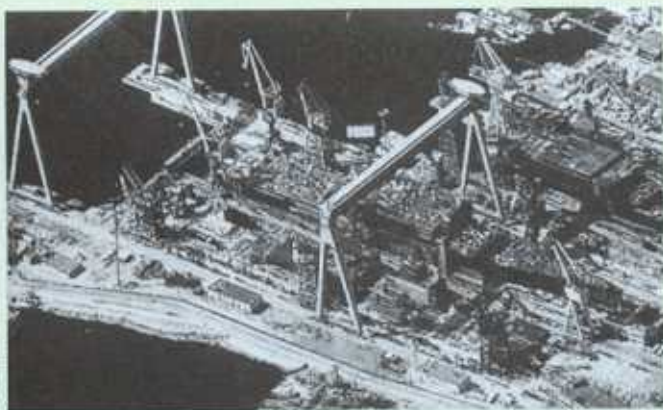
O imagine de pe satelitul SUA KH-11 (stânga) arată construcția unei nave portavion sovietice cu propulsie nucleară într-un port la Marea Neagră. Imagini făcute la 250km înălțime pot să prezinte detalii ce au doar 30 cm diametru.
