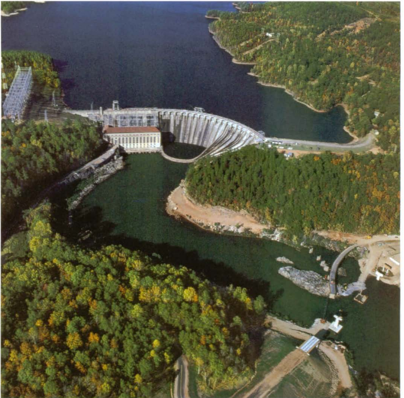
Dig pe Lacul Martin, Alabama
