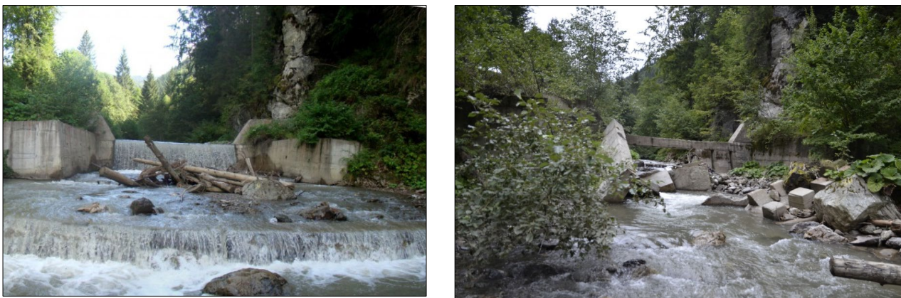
Figura 2. Lucrarea 170 BF 2,0 - Valea Repede: a - înainte de viiturile din anul 2012 (Anul 2010 (Foto: Davidescu), Y_s = 78,62 ); b - după viiturile din anul 2012 (Anul 2017 (Foto: Mihalache), Y_s = 41,98 )
