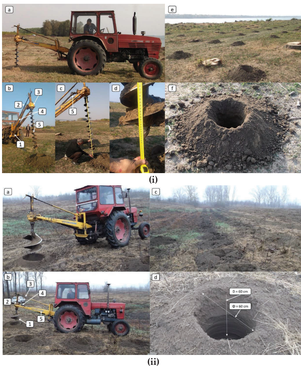
Figura 1. Descrierea echipamentelor utilizate, a operațiilor realizate și a dimensiunilor gropilor. Legendă: (i) gropi pentru sade: a – agregatul folosit, b – detalii ale mașinii de săpat (1 – cadru, 2 – dispozitiv de ajustare, 3 – corpul mașinii; 4 – cadru lateral; 5 – burghiu), c & d – detalii ale sistemului de transmisie și ale burghiului, e – imagine de ansamblu a suprafeței după operare, f – groapă pentru sade; (ii) gropi pentru puiți: a – agregatul folosit, b – detalii ale mașinii de săpat și ale burghiului (1 – burghiu, 2 – corpul mașinii, 3 – dispozitiv de ajustare; 4 – sistem de transmisie; 5 – cadru lateral), c – imagine de ansamblu a suprafeței după operare; d – elementele dimensionale ale unei gropi
