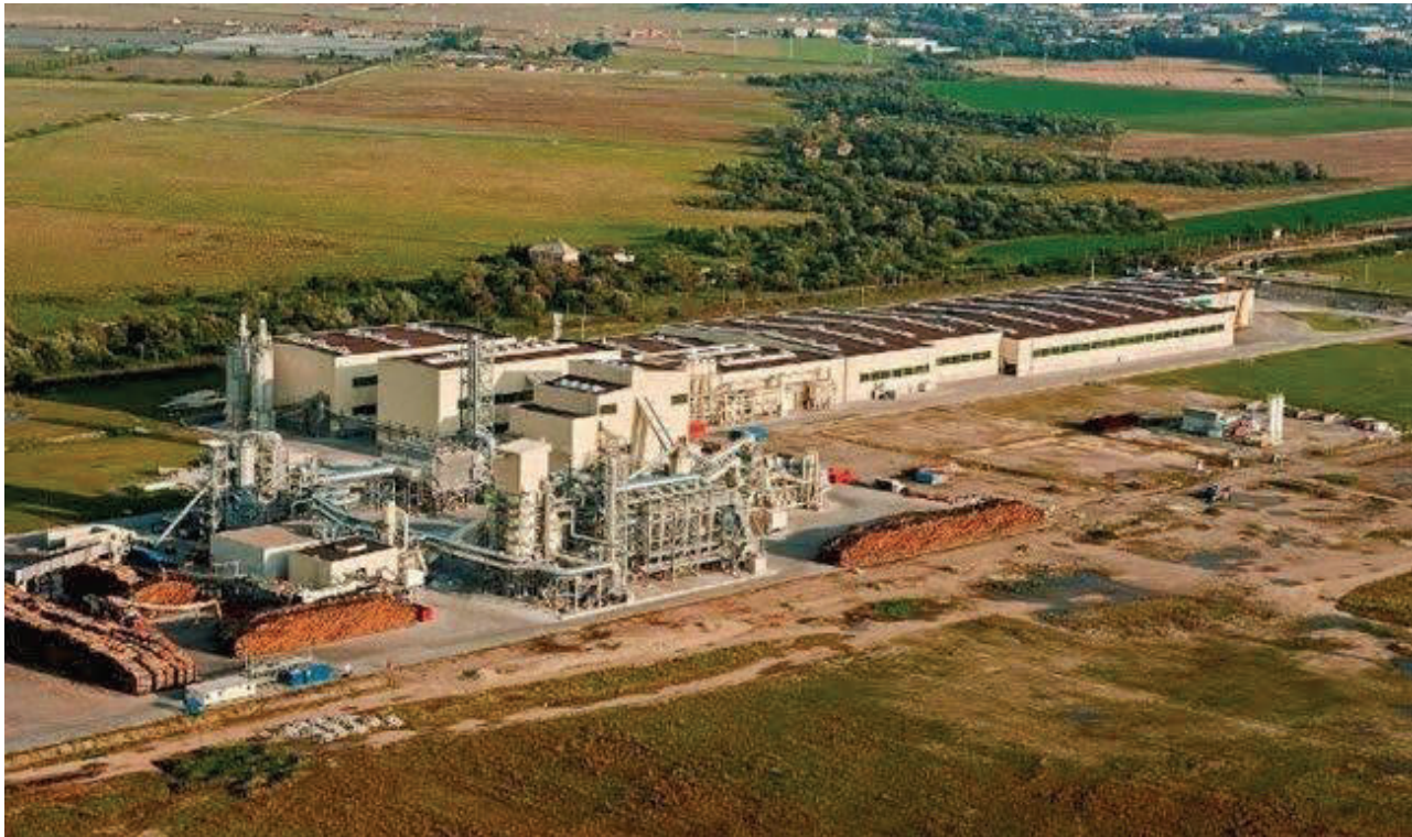
Figura 1. Fabrica Kronospan Trading Brașov. Sursa: [11].
