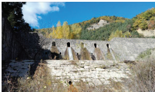
Foto 4. Câteva din lucrările hidrotehnice „restaurate” pe torentul Arás, după viitura catastrofală din 1996.
