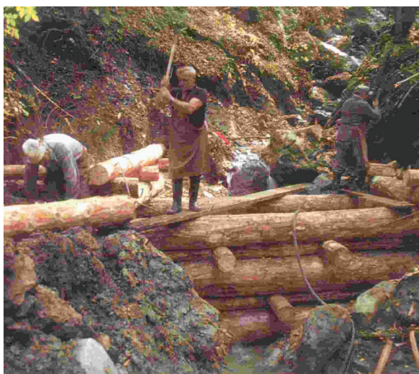
Fig. 5. Baraj din lemn, în curs de execuție (foto: Anonim)
